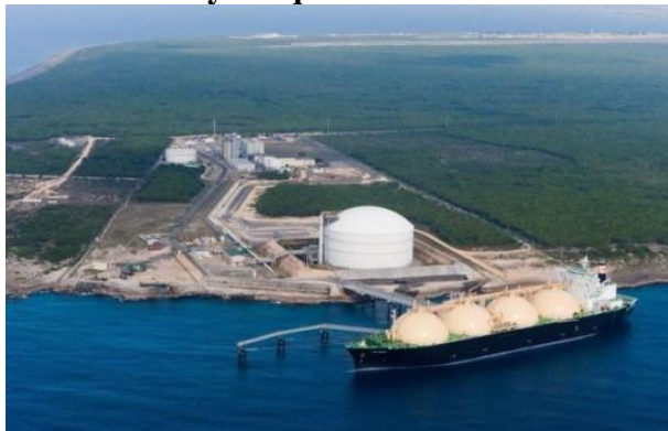
Imagen No. 12. Metanero y tanque de almacenamiento en AES Andrés
