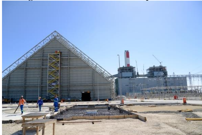
Imagen No. 18. Almacén cerrado para carbón
