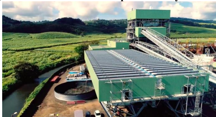
Imagen No. 8. Aerocondensador para enfriar y secar biomasa
