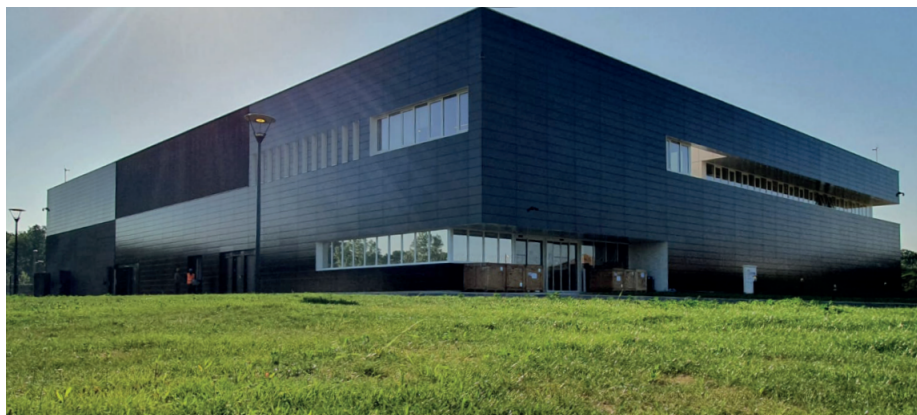
FIGURE 1.1 – Centre de Surveillance de la Sécurité Galileo (2022)
