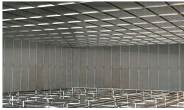
(a) Cage de Faraday de type modulaire ( holland-shielding.com )
