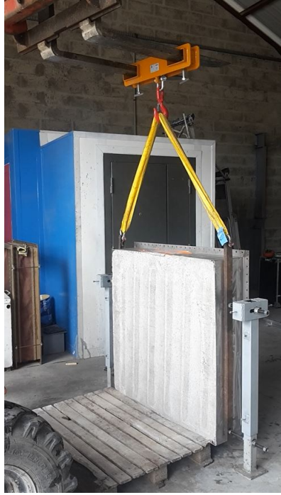
FIGURE 1.7 – Bloc de béton fibré coulé dans son cadre métallique, et prêt à être monté sur la cage de Faraday
