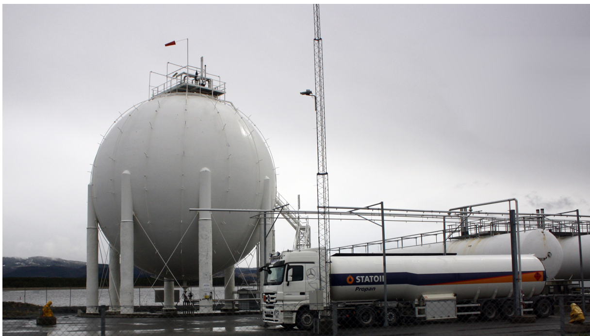
FIGURE 1.7 – Modalités de stockage et de transport de l'hydrogène sous forme liquide
