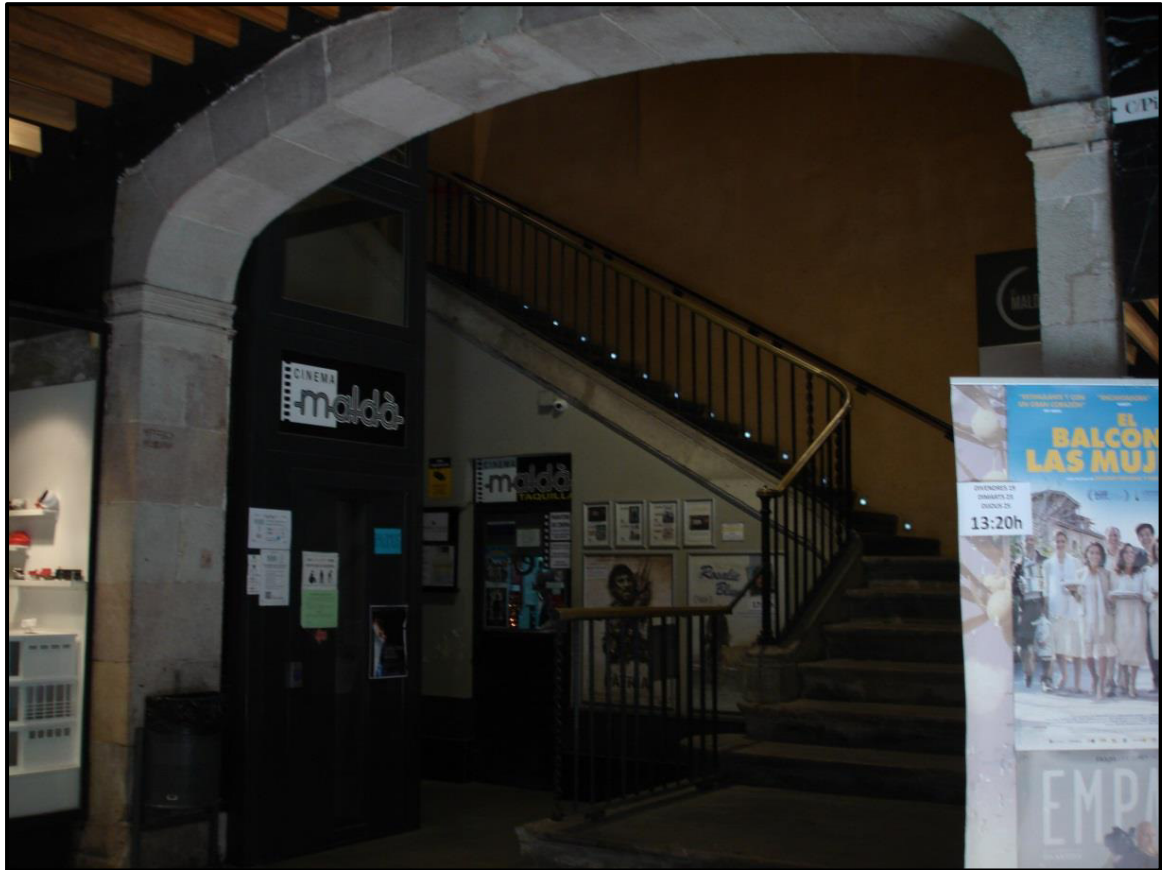
Figure 8.2. Casa Cortada . État actuel de l'escalier principal. Photographie de l'auteur.
