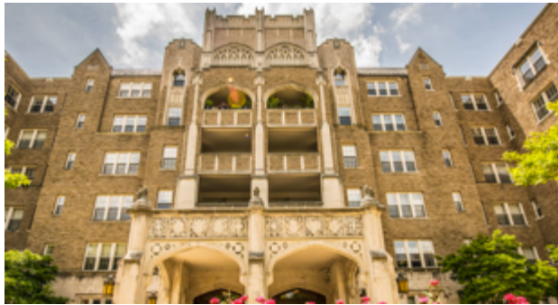
Figure 182 - Façade néogothique de l'Alban Towers
