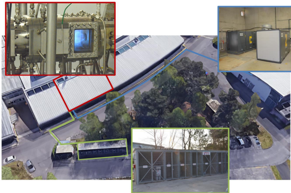
FIGURE 3.2 – Vue aérienne des infrastructures alimentant le banc de combustion HERON (cadre rouge : banc de combustion HERON, cadre bleu : local compresseurs, cadre vert : local carburants)
