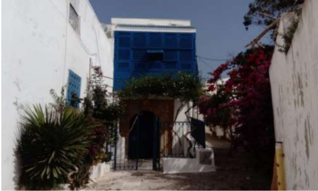
FA 2. Façade nord-ouest
