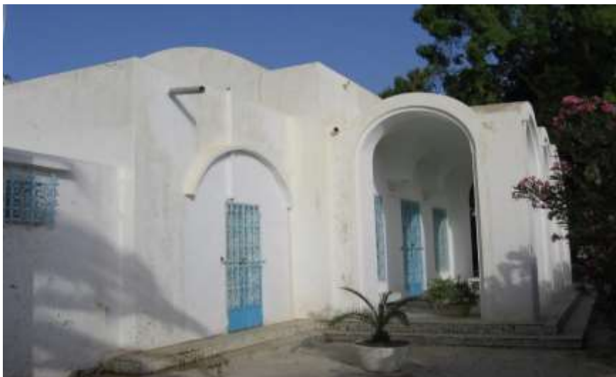
LA 3. Façade principale de la demeure Source : Crédit photographique de l'auteur
