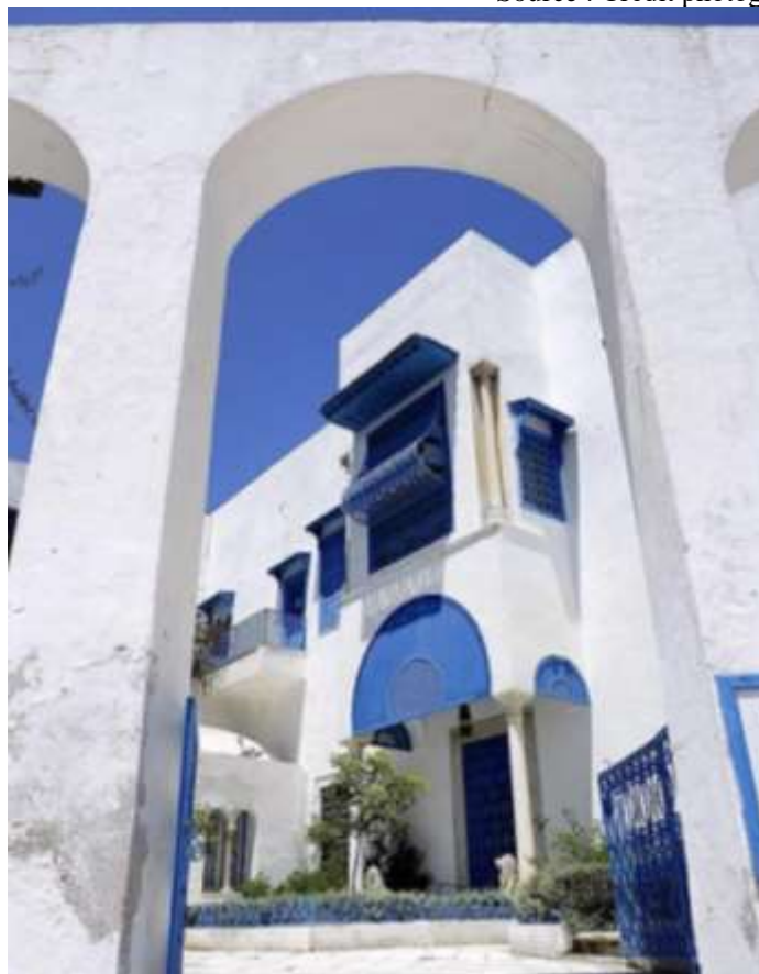
EN 12. Vue de la façade sud-ouest du palais Source : Crédit photographique de l'auteur
