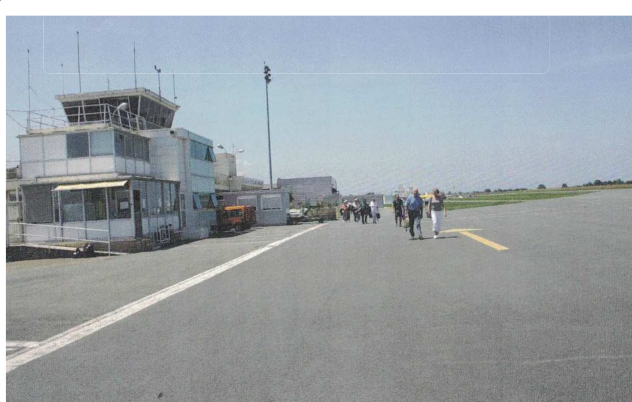
Photo 12 : Aéroport de Bergerac en 2000
