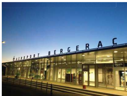
Photo 13 : Aéroport de Bergerac en 2020
