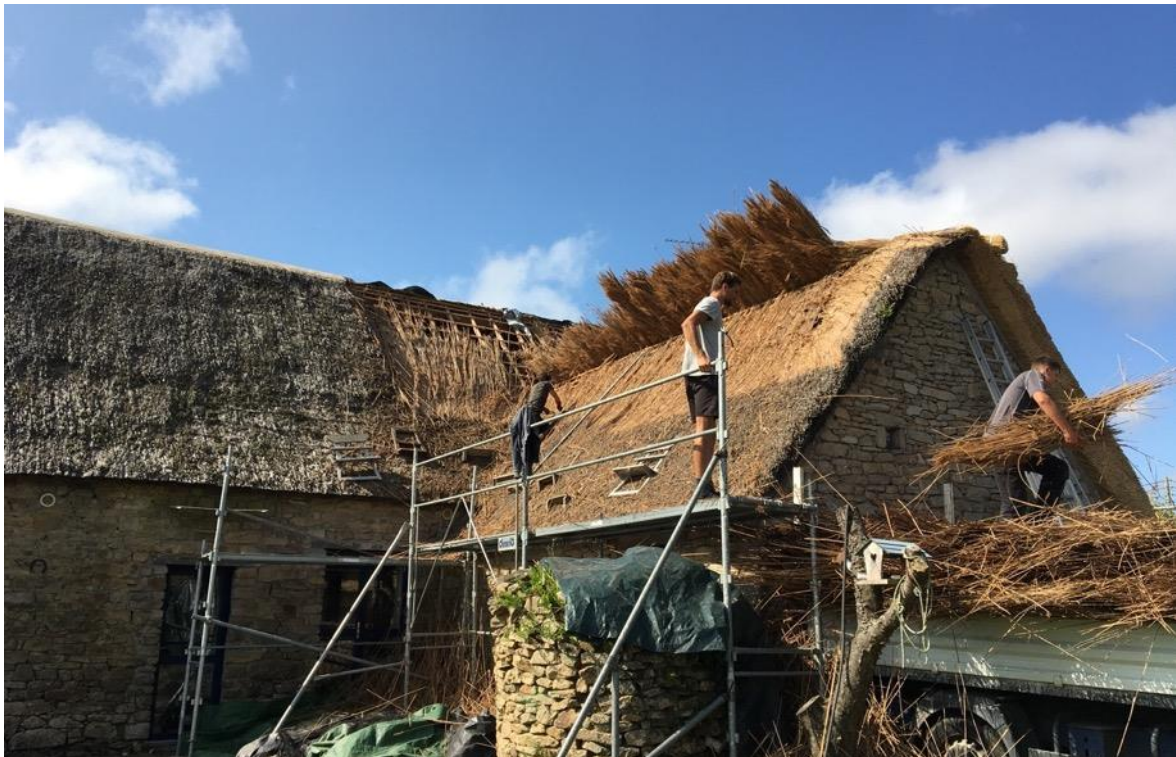
Figure 9 : Chantier avec l'équipe de Cyril Crusson (Mazerac), 2021, crédit Carole Lemans
