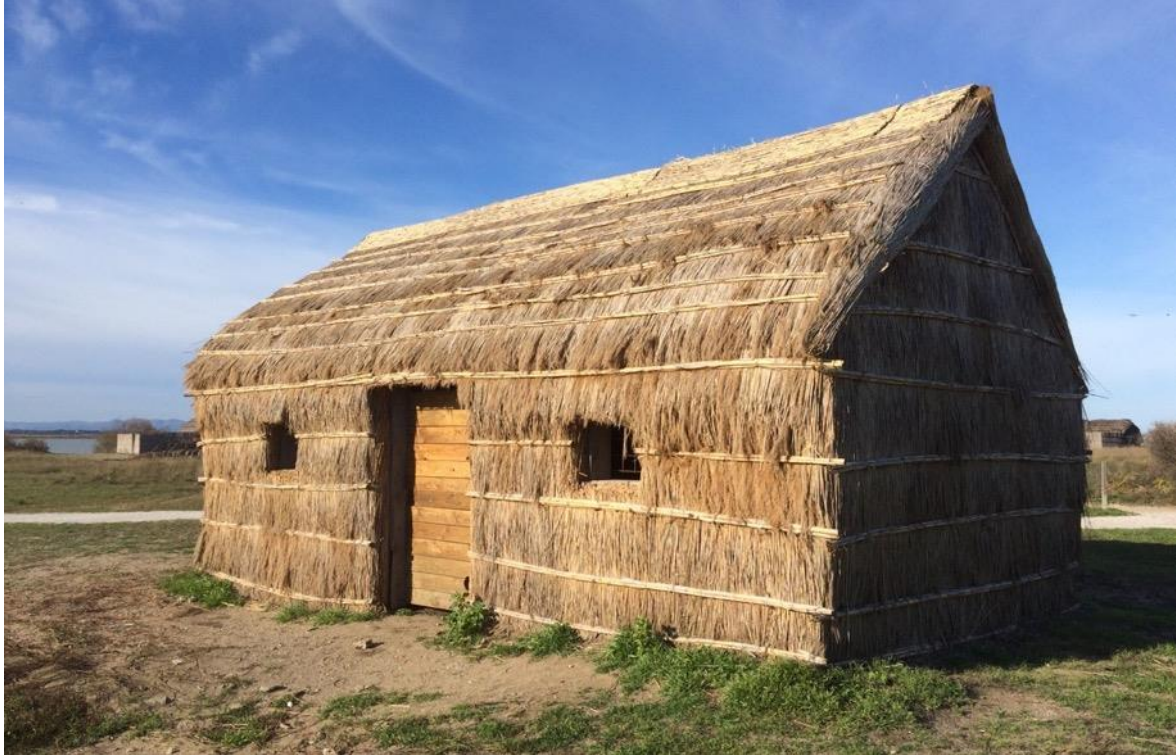
Figure 32 : Cabanes de pêche réhabilitées en 1993 (étang de Canet Saint-Nazaire), 2021, crédit Florent Marie
