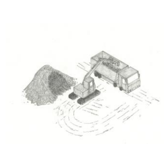
4 Chargement de la terre nécessaire à la confection de l'isolant et à la réalisation de l'enduit
