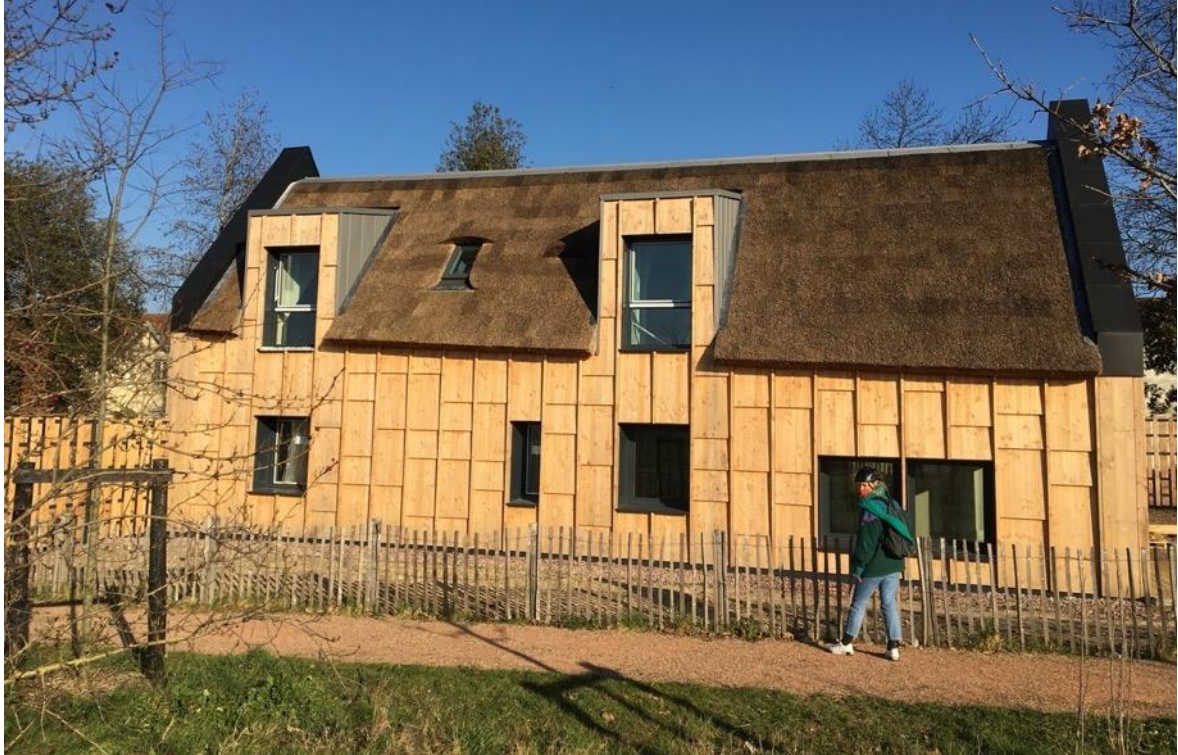
Figure 109 : Maison maraîchère, APM (Saint-Étienne-du-Rouvray), 2021, crédit Carole Lemans
