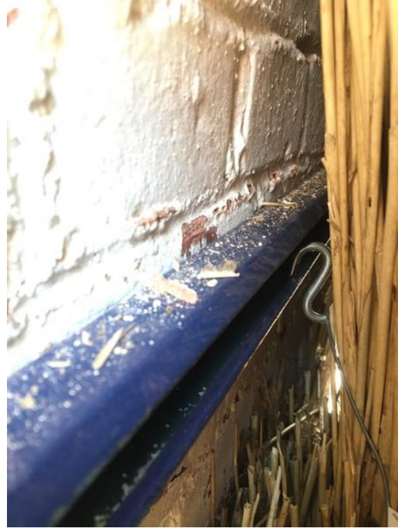
Figure 216 : Installation des crémaillères recevant les panneaux, 28/04/21, crédit Carole Lemans
