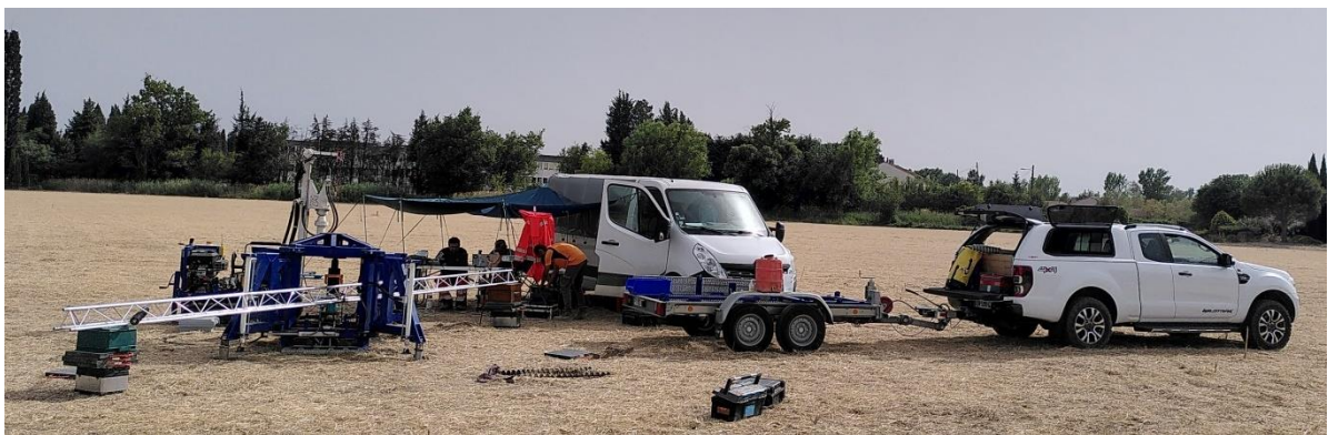
Figure V-2. Vue générale d'un essai de chargement de fondation à Avignon.
