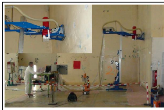
Figure 6 : Démonstration de fonctionnement de l'Aspilaser (procédé breveté par le CEA) à l'atelier de traitement de l'uranium de Cadarache (décontamination d'une peinture sur un béton) [1].
