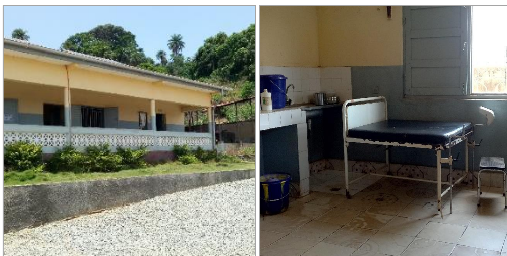
Figure 20 : Etat extérieur du premier bâtiment (gauche) et table d'accouchement (droite), Centre de santé de Bowa, 25 mars 2020, Barranca
