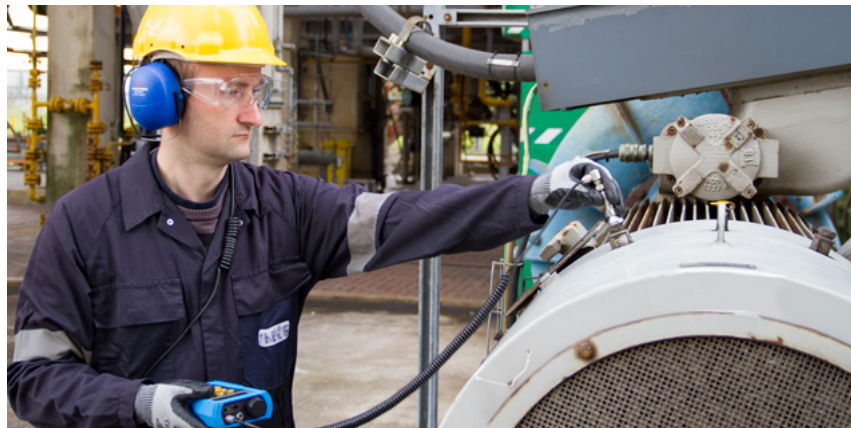
FIGURE 1.17 – Mesure par ultrasons (photo fournie par STD International sa-nv)
