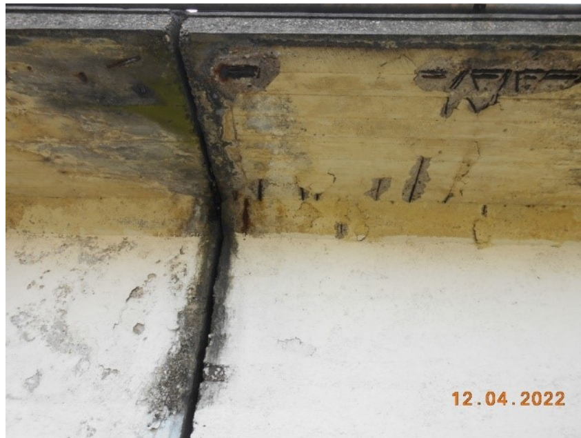
Figure 8 Effet de l'attaque sulfatique externe (échelle macroscopique)
