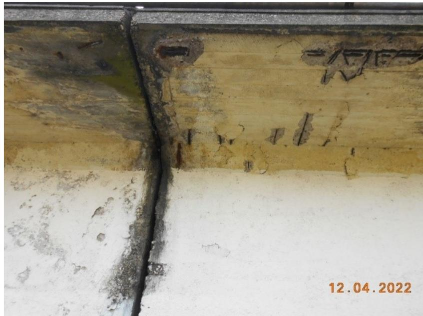
Figure 8 Effet de l'attaque sulfatique externe (échelle macroscopique)
