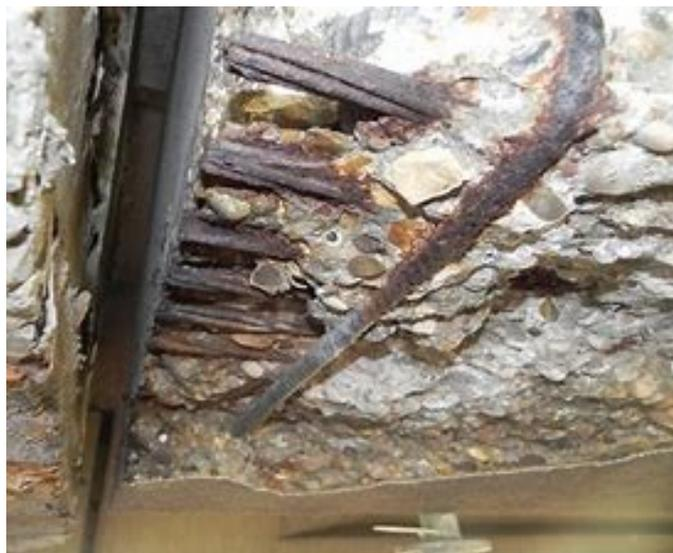
*Figure 2 Béton détérioré par attaque sulfatique*
