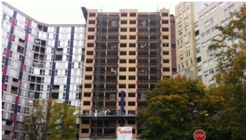
Figure 21 : L'aile du 50 Arlequin en cours de démolition. Photographie : Isabelle Guyader. Source : « A la Villeneuve de Grenoble, la démolition de l'aile nord de la galerie de l'Arlequin est en cours », France 3 Auvergne Rhône Alpes, publié le 14 novembre 2013.
