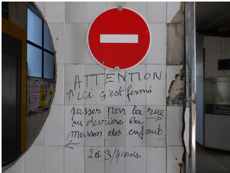
Figure 29 : Indications écrites au feutre sur les murs de l'entrée du 40 Arlequin, suite à l'installation de l'enclos de chantier qui modifie les cheminements dans la galerie et aux alentours. Photographie Mailys Toussaint, 19 mars 2016.
