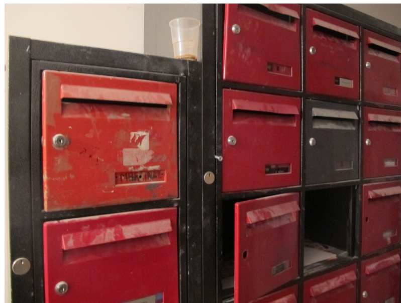
Figure 33 : Boîtes-aux-lettres dans les coursives en chantier du 40 Arlequin. Photographie Mailys Toussaint, 22 octobre 2016
