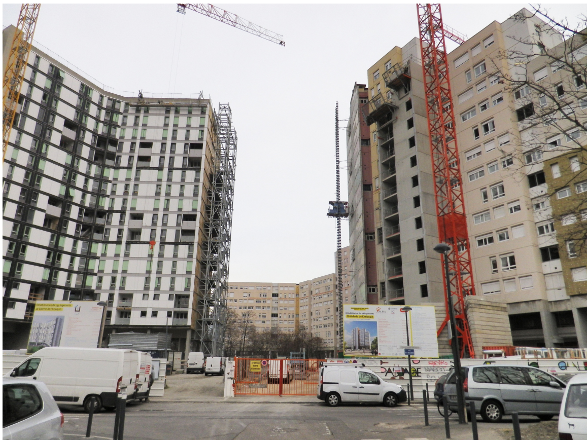
Figure 23 : Le trou laissé par la démolition de l'aile du 50, le 40 Arlequin (à gauche) et 50 Arlequin (à droite) en réhabilitation en site habité. Photographie Maïlys Toussaint, 28 janvier 2016.
