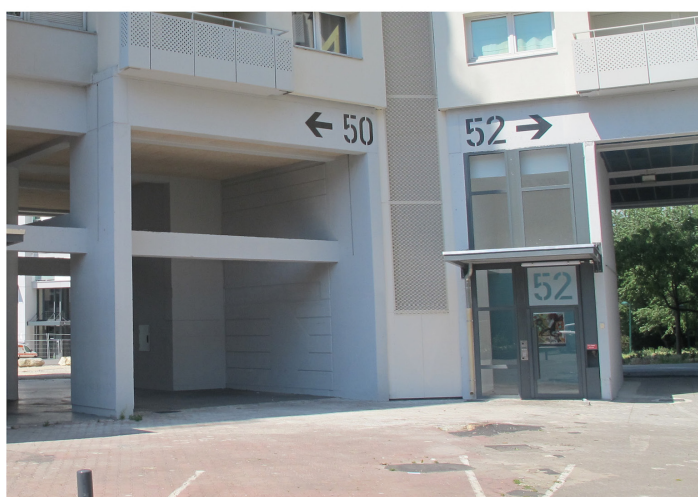
Figure 31 : Exemple de reconduction photographique. Vue sur la nouvelle entrée du 50 Arlequin. Photographie Maïlys Toussaint, (1) 11 novembre 2015, (2) 14 juin 2016, (3) 10 juin 2017.
