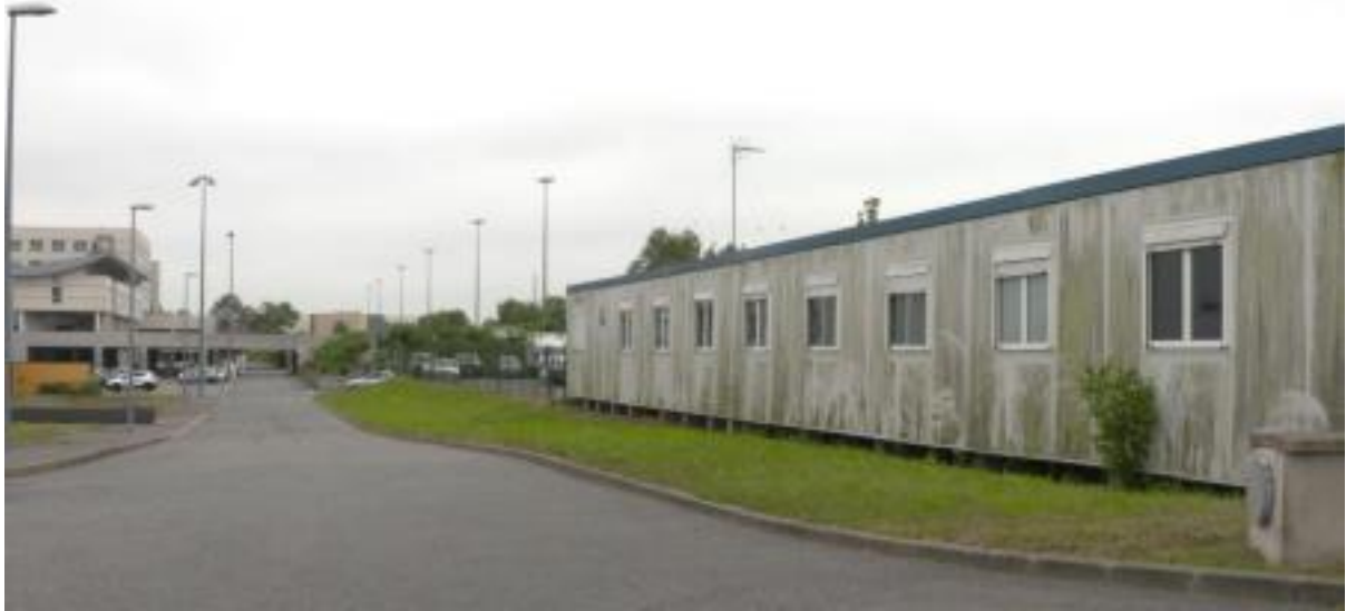
À gauche, le corps principal du nouvel hôpital installé en 2012. À droite, les murs verdâtres de la PASS de Calais. ©Chloé Tisserand
