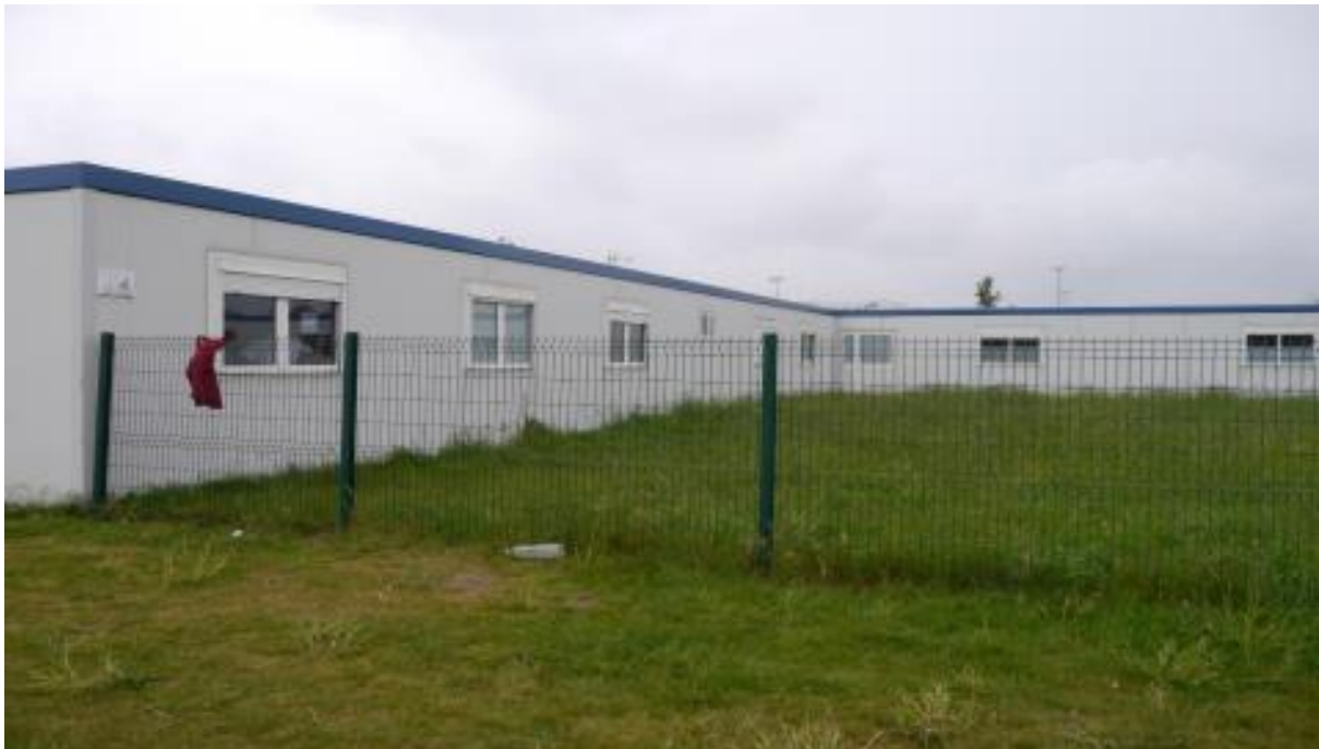
Le modulaire de la permanence d'accès aux soins de santé du centre hospitalier de Calais. ©Chloé Tisserand
