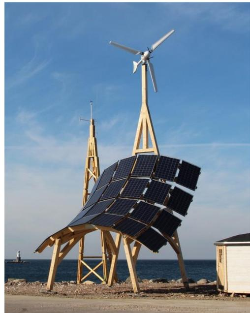
Figure 265. La Girafe de l'entreprise suédoise Innoventrum, un dispositif hybride de production d'énergie éolien et photovoltaïque créant aussi un carport
