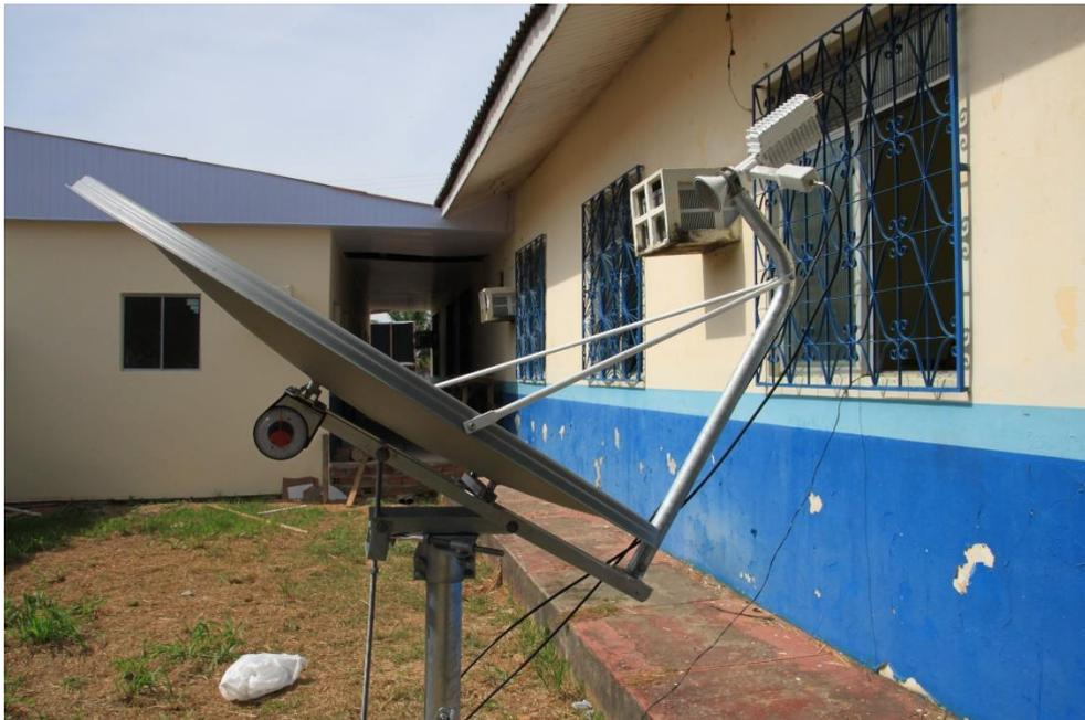
*Figure 47: Rapporteur d'angle accroché à la parabole*
