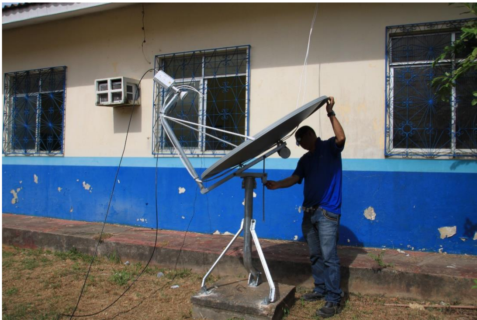
Figure 48 - Anderson en train de chercher le signal de satellite pour la parabole
