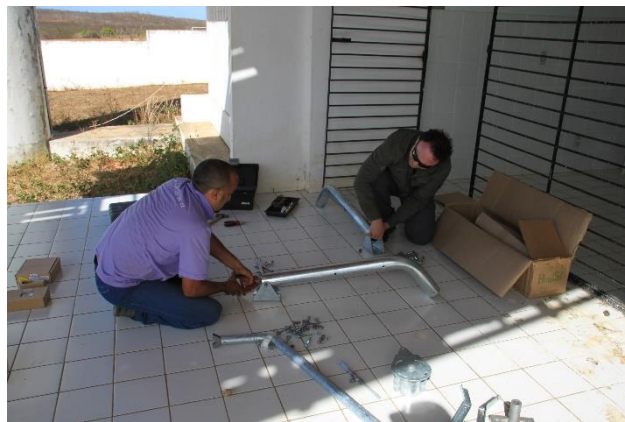
Figure 37 : Carlos et Fernando en train de monter la structure de la parabole
