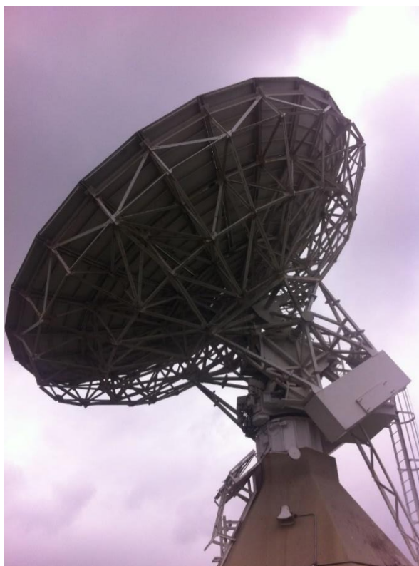
Figure 22 : Une très grande antenne de réception de signaux à Guaratiba
