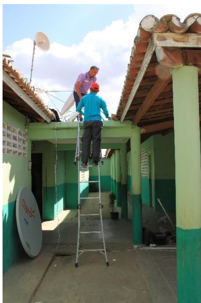
Figure 40 : Les techniciens en train de décider l'emplacement de la parabole
