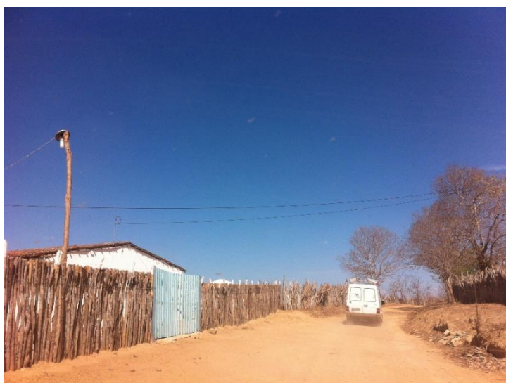
Figure 34 : Maison avec fourniture d'énergie électrique.
