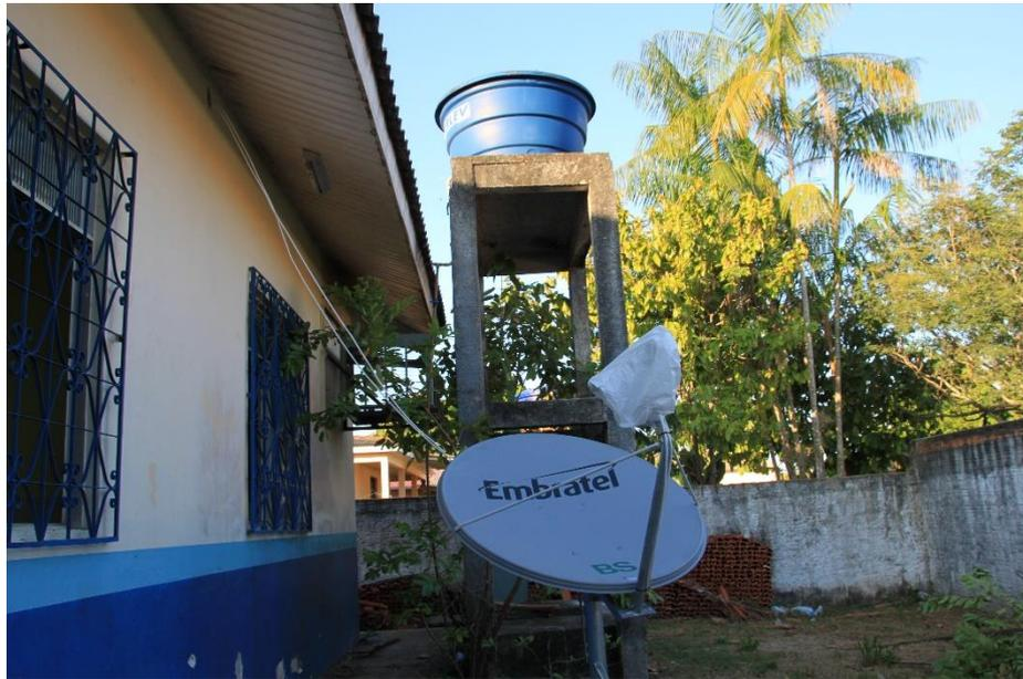
*Figure 46 - La parabole protégée par un sac plastique*
