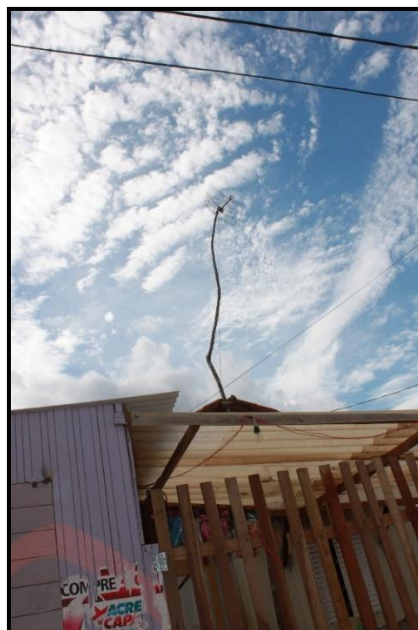
Figure 8: Une antenne pour connexion résidentielle du Floresta Digital attachée à une tige de bambou, à Rio Branco (Acre) en 2012. L'instabilité de l'antenne entrave la connexion.
