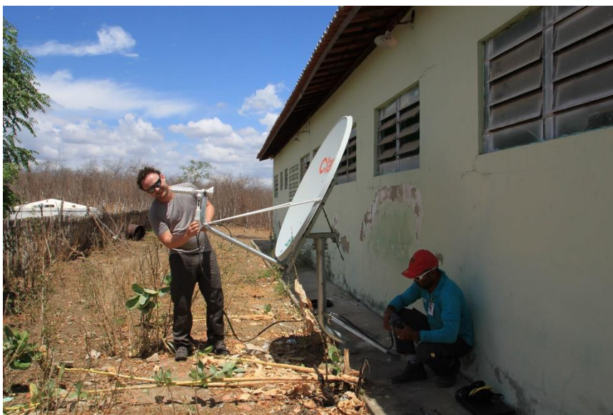
Figure 44 : Fernando en train de chercher le signal du satellite pendant que Paulo regarde le modem pour vérifier la qualité du signal
