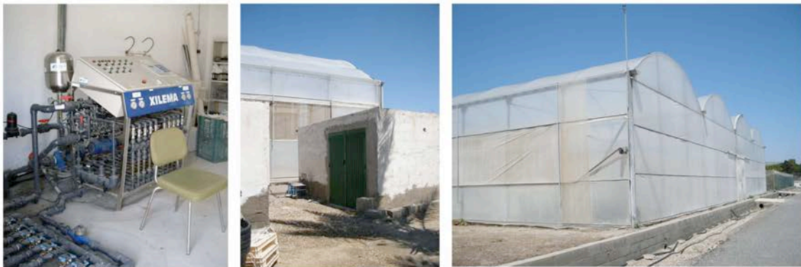
Otras estructuras modernizadas
