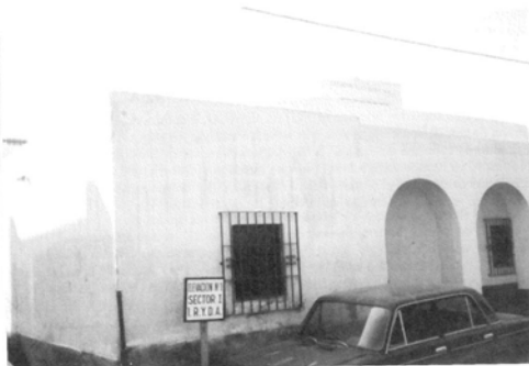
Estación elevadora n° 1. Venta Vitorino Aguadulce en 1986
