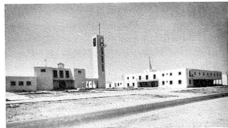
Plaza abierta a la carretera o al paisaje, normalmente situada a la entrada del pueblo, y en cuya primera línea se manifiestan sus edificios más representativos. Es el caso de ésta imagen de Camponuevo del Caudillo, y también de El Solanillo, Pueblo blanco o San Isidro de Nijar.
