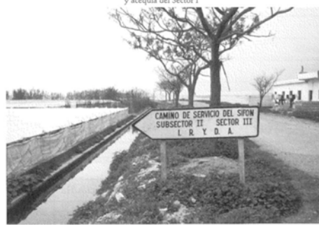
Canal del Sector III-1. De aquí parte del sifón que lleva el agua a la ampliación de este Sector.
