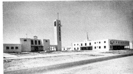
Plaza abierta a la carretera o al paisaje, normalmente situada a la entrada del pueblo, y en cuya primera línea se manifiestan sus edificios más representativos. Es el caso de ésta imagen de Camponuevo del Caudillo, y también de El Solanillo, Pueblo blanco o San Isidro de Nijar.
