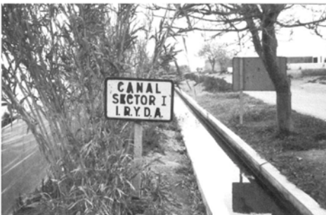
Canal principal del sector I en 1986
