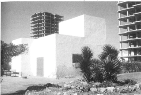
Pozo del Grupo de elevaciones n° 2 en Aguadulce en 1996
