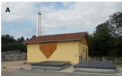
Vue extérieure d'une chaufferie avec ses 2 silos enterrés
