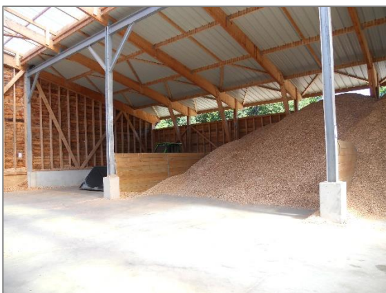
4- Stockage des plaquettes, sous un hangar, pour assurer leur séchage
