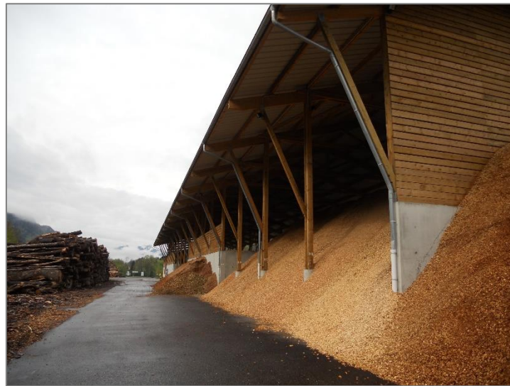
Photo 41 - La plateforme de stockage de bois-énergie de Saint-Thibaud-de-Couz (Savoie)
