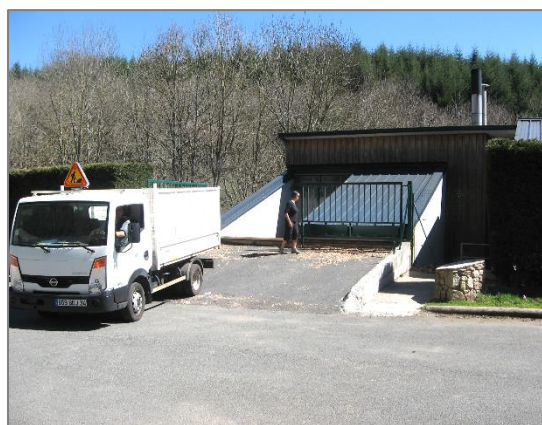
Photo 24 - Silo semi-enterré de la chaufferie de Fraïsse-sur-Agout (Hérault)
