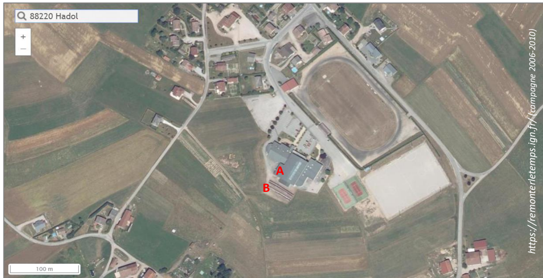
Photo 20 - Vue aérienne du site d'implantation de la chaufferie d'Hadol (Vosges)
