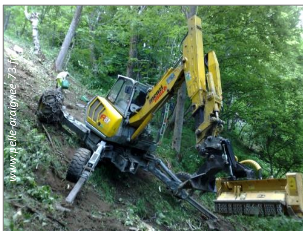
Photo 34 - Exemple d'une pelle araignée
