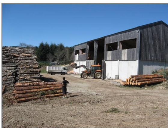
Photo 23 - Hangar de stockage de Fraïsse-sur-Agout (Hérault)
