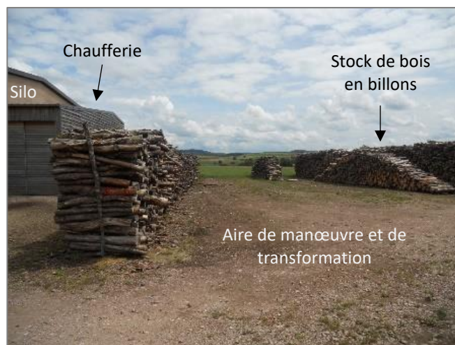
Photo 21 - Zone de stockage du bois et de préparation de la plaquette à Hadol (Vosges)
