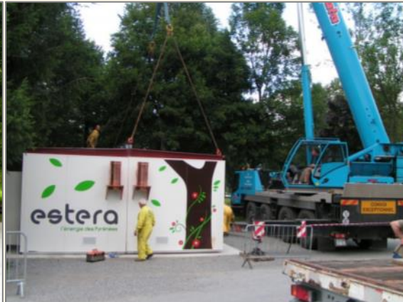
Livraison et assemblage des modules sur le parking de Balnéa
