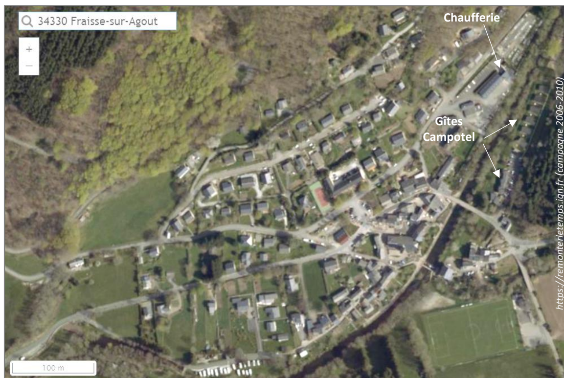
Photo 22 - Vue aérienne du site d'implantation de la chaufferie de Fraïsse-sur-Agout (Hérault)
