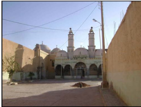
Zaouïa El Mokhtaria en mars 2008 après sa restauration et son extension
