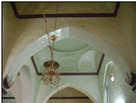
Détail intérieur de la mosquée donnant sur les chambres des élèves
