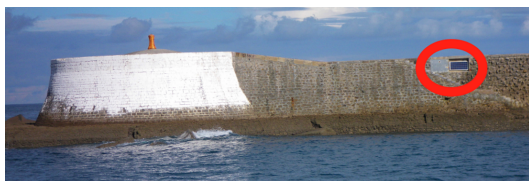
(A) Station de supervision de la digue de l'Artha. Les capteurs sont de l'autre côté du musoir peint en blanc.
