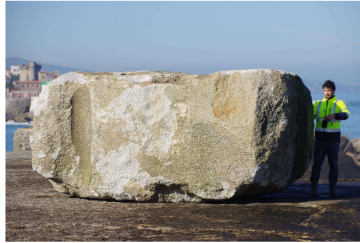
(B) Bloc de béton de 50 tonnes déposé sur la digue de l'Artha en 2017.
