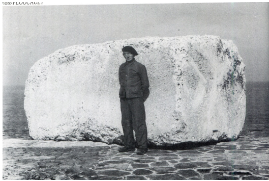
(A) Bloc de béton de 40 tonnes déposé sur la digue de l'Artha lors de la tempête de 1951.
