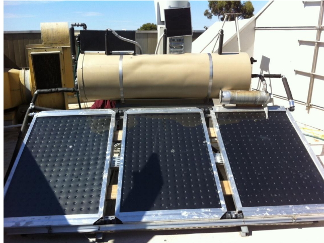
FIGURE 2.20 – Chauffe eau solaire utilisé pour les expériences à distance chez FarLabs.
