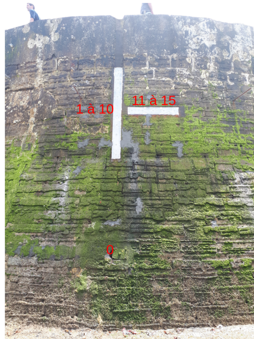
(C) Installation des seize capteurs sur le musoir nord-ouest. Le capteur zéro est en bas.
