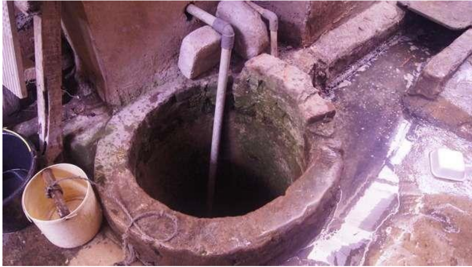
Puits chez un Bugis à Kali Baru
