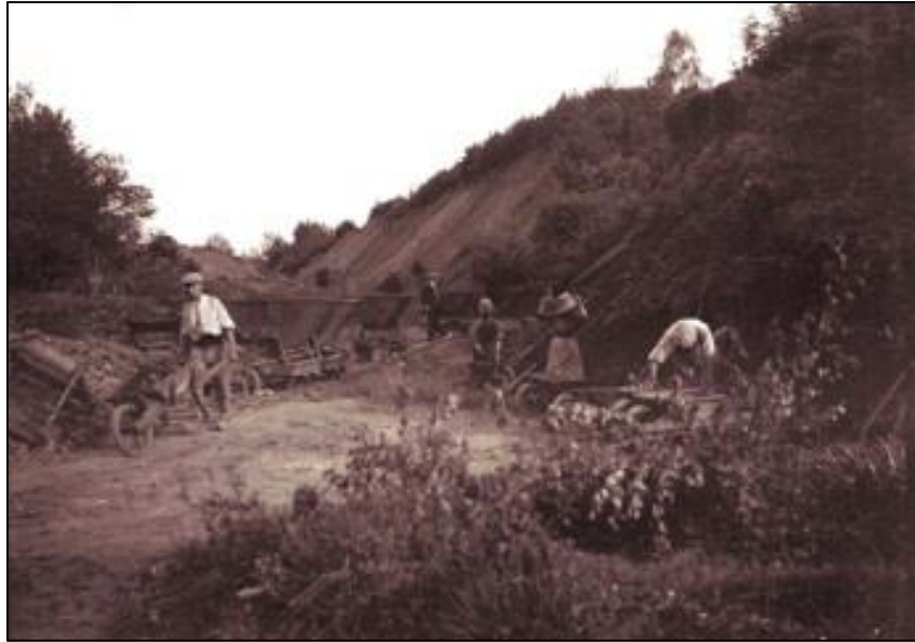
Figure I-2 : Exploitation du grand ferrier de Tannerre-en-Puisaye au début du XXe siècle : chantier belge, mai 1916 (collection J. Rapin).
