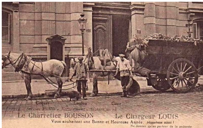
Figure 19: collecte à cheval des ordures ménagères (1914) - Source : Hippotese
