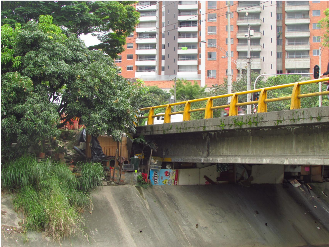
Photo 27 : Vues extérieurs du ranchito sous le pont de la carrera 65 côté Sud.
