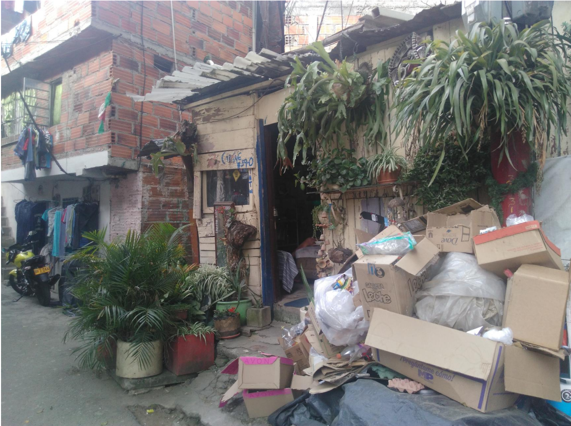
Photo 25 : Ranchitos de la calle 59 dans el barrio Nueva Villa la Iguaná.
