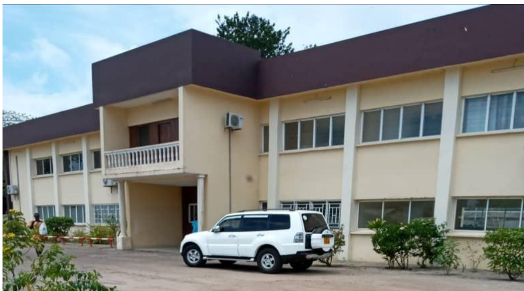
Figure 20: Siège provincial du PDG de l'Ogooué Maritime, à l'ouest du Gabon
