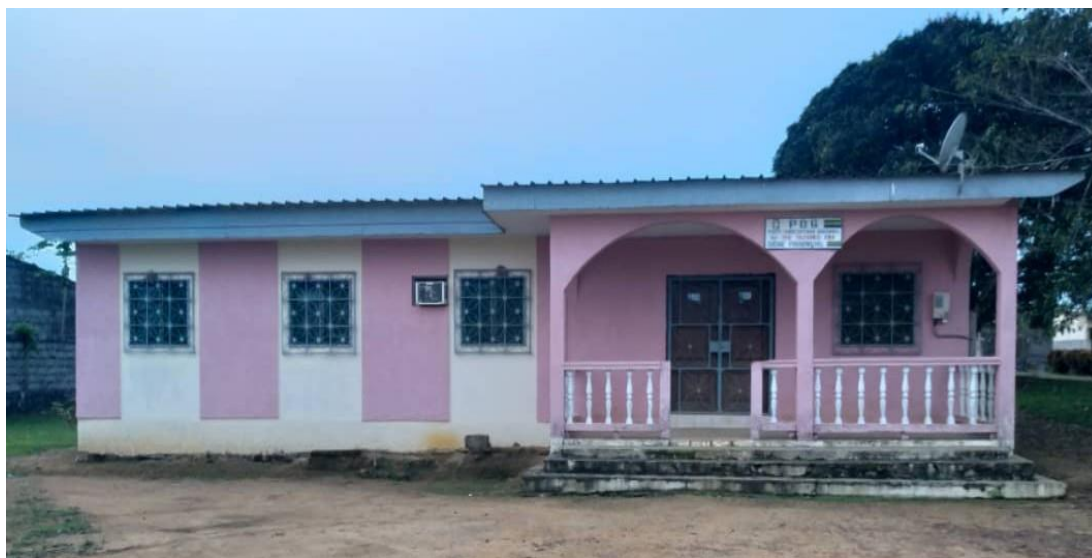
Figure 19 : Siège provincial du PDG de l'Ogooué Ivindo, au nord-est du Gabon
