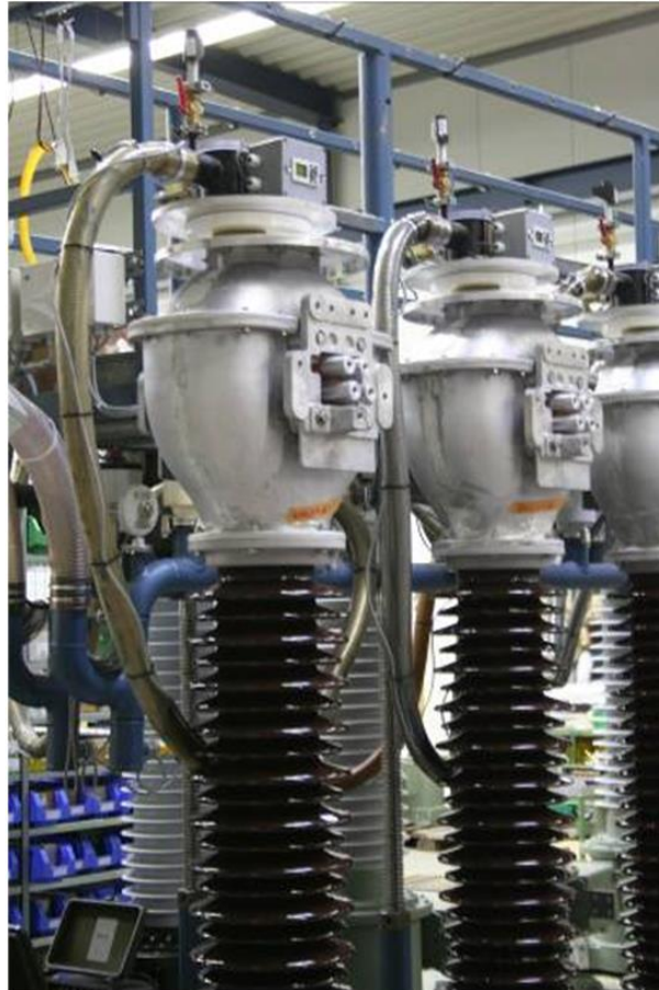
Figure 16 - Remplissage sous vide de l'appareil avec l'huile isolante circulant dans le tuyau
