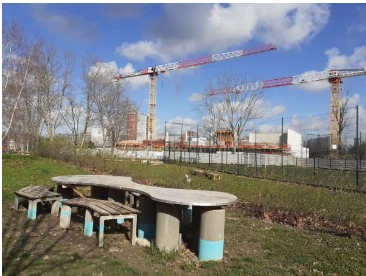
Photo 48 - Le chantier de la médiathèque, 18/02/2020
