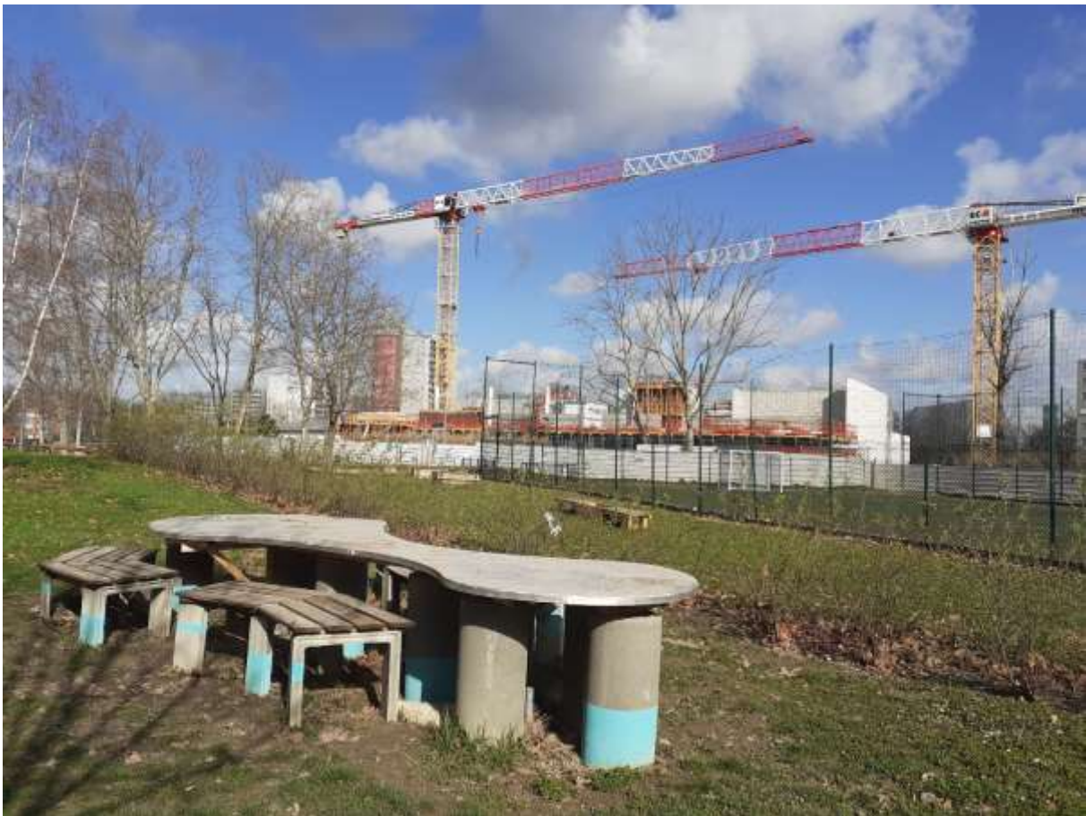
Photo 48 - Le chantier de la médiathèque, 18/02/2020
