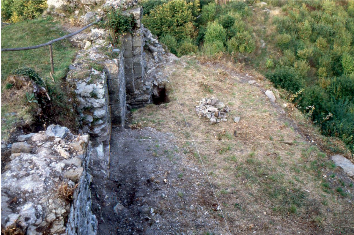
Fig. 39: Vue de la chapelle de Château-Vieux d'Allinges. Cliché : J. Laidebeur.
