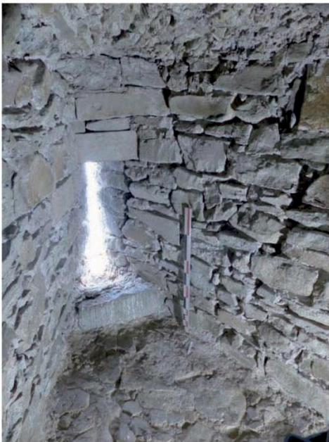
Archère à simple ébrasement à Bonneville. Cliché: S. Bocquet.
