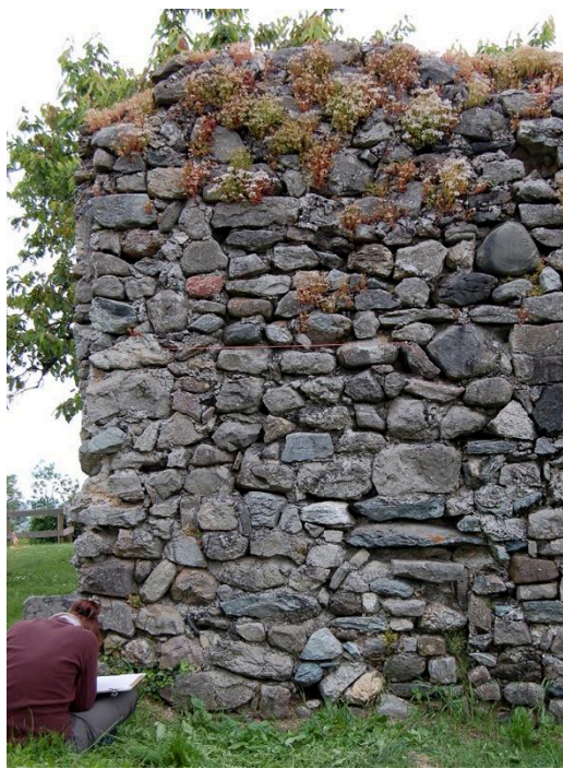
Fig. 44: Relevé du mur supposé de la maison forte des Allinges à Château-Neuf. Cliché : L. Benoit.
