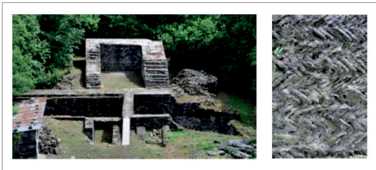
Fig. 14: Vue de Langin et détail de l'appareil de construction. Clichés : L. D'Agostino.
