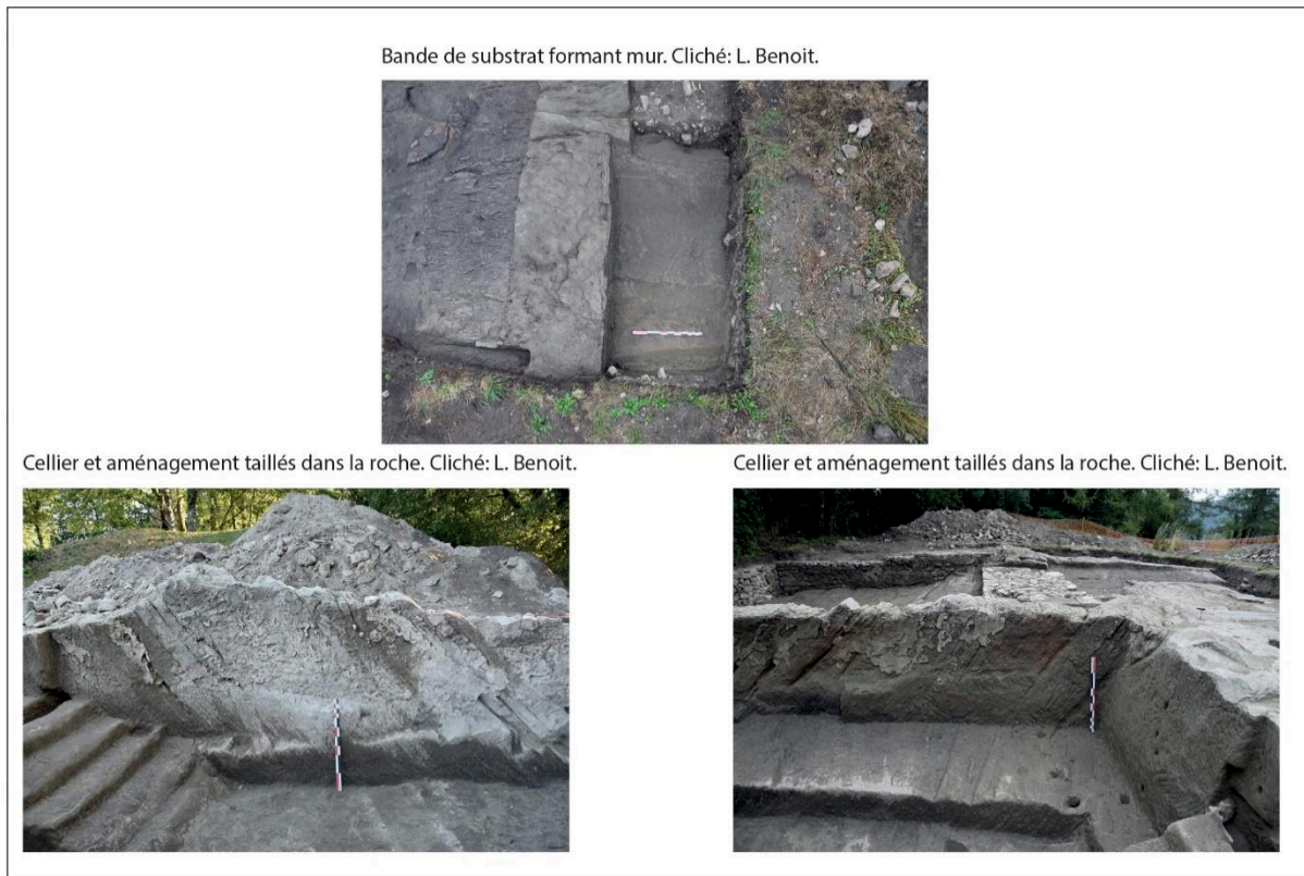
Fig. 47: Exemples d'aménagements du substrat géologique au château de Clermont.
