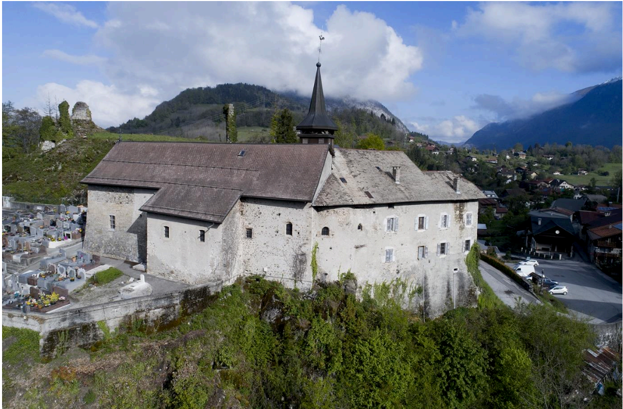
Fig. 45: Eglise de Châtillon logée au sein du plain château et cour haute en arrière-plan. Cliché : O. Veissière.
