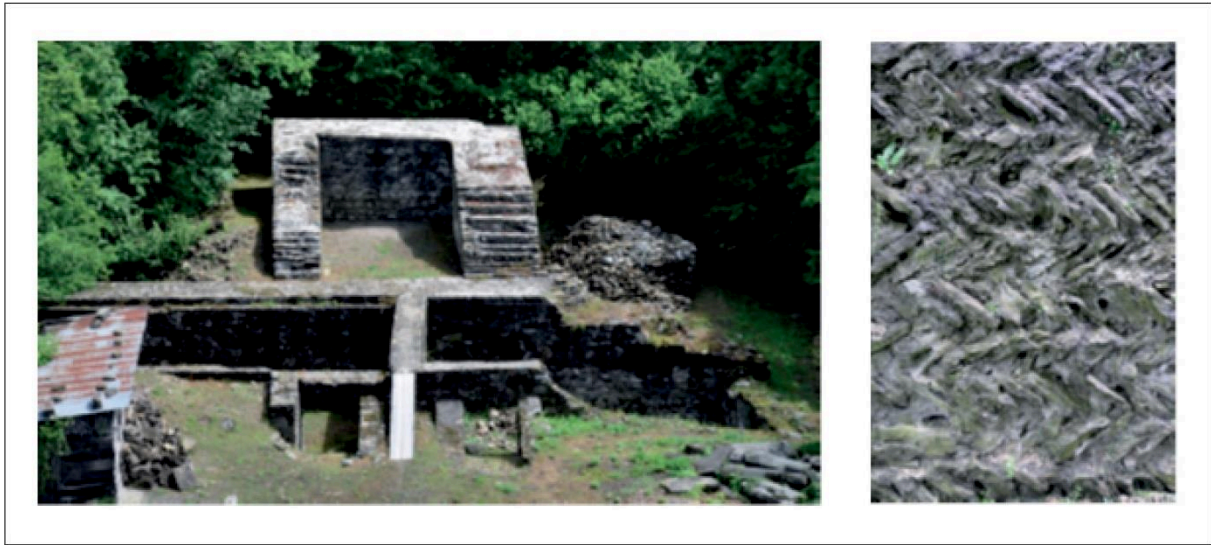
Fig. 14: Vue de Langin et détail de l'appareil de construction. Clichés : L. D'Agostino.
