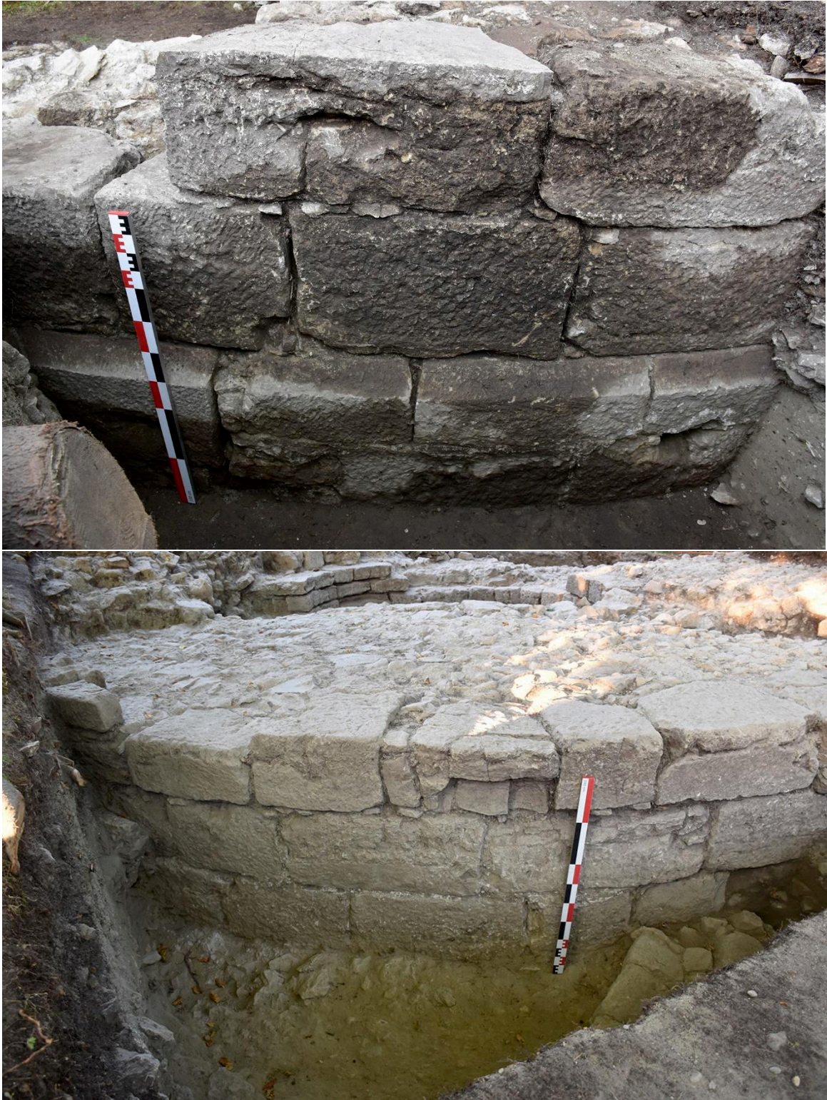
Fig. 6: Parements extérieurs de la tour maîtresse. Cliché : L. Benoit.
