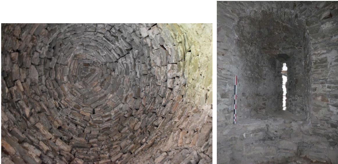
Fig. 16: Voûte maçonnée et archère du niveau inférieur. Clichés : L. Benoit et S. Bocquet.
