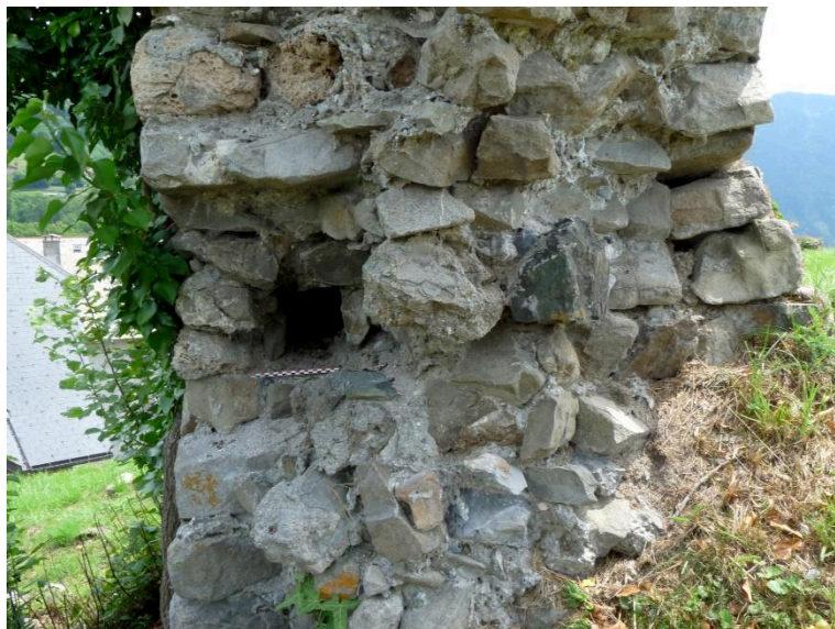
Fig. 9: Trou de poutre de fermeture dans l'une des failles du mur de logis. Cliché : A. Lorphelin.
