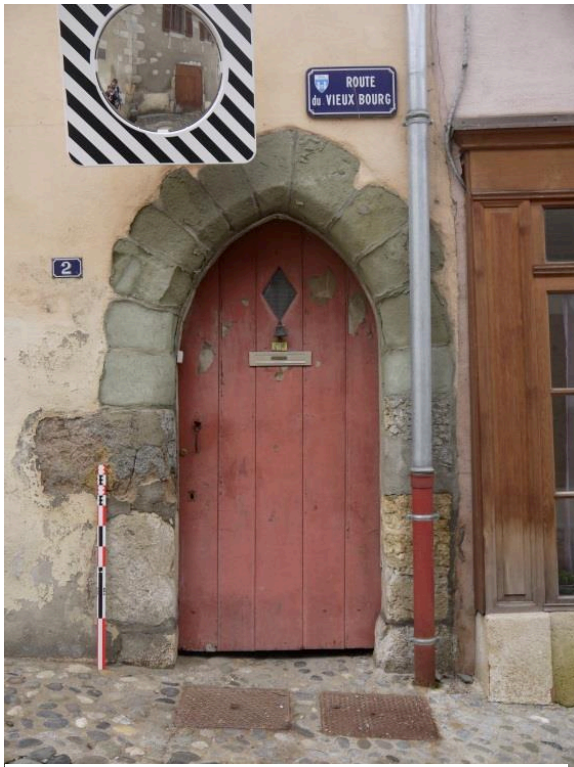
Fig. 9: Porte en arc brisé en molasse et calcaire. Cliché : L. Benoit.
