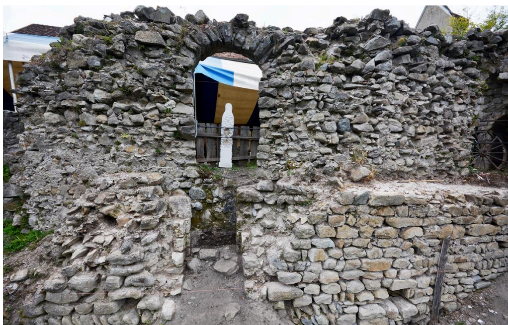
Fig. 20: Parement extérieur de la cour haute et ouverture en tuf. Cliché : L. Benoit.
