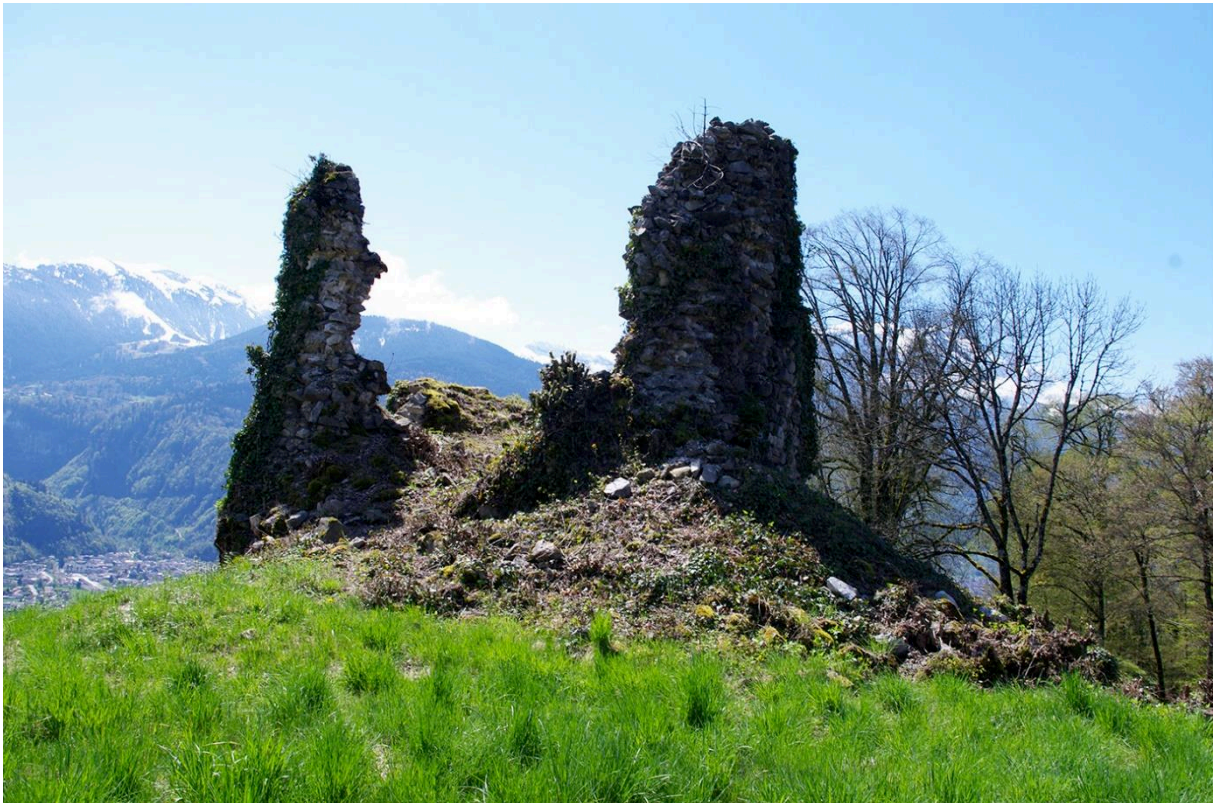
Fig. 3: Vue générale de la tour maîtresse de Châtillon. Cliché : L. Benoit.
