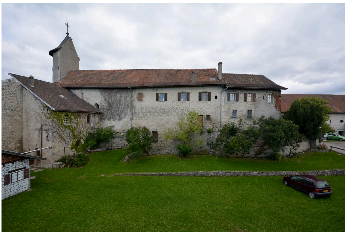
Fig. 19: Courtine nord-ouest de la cour haute. Cliché : L. Benoit.
