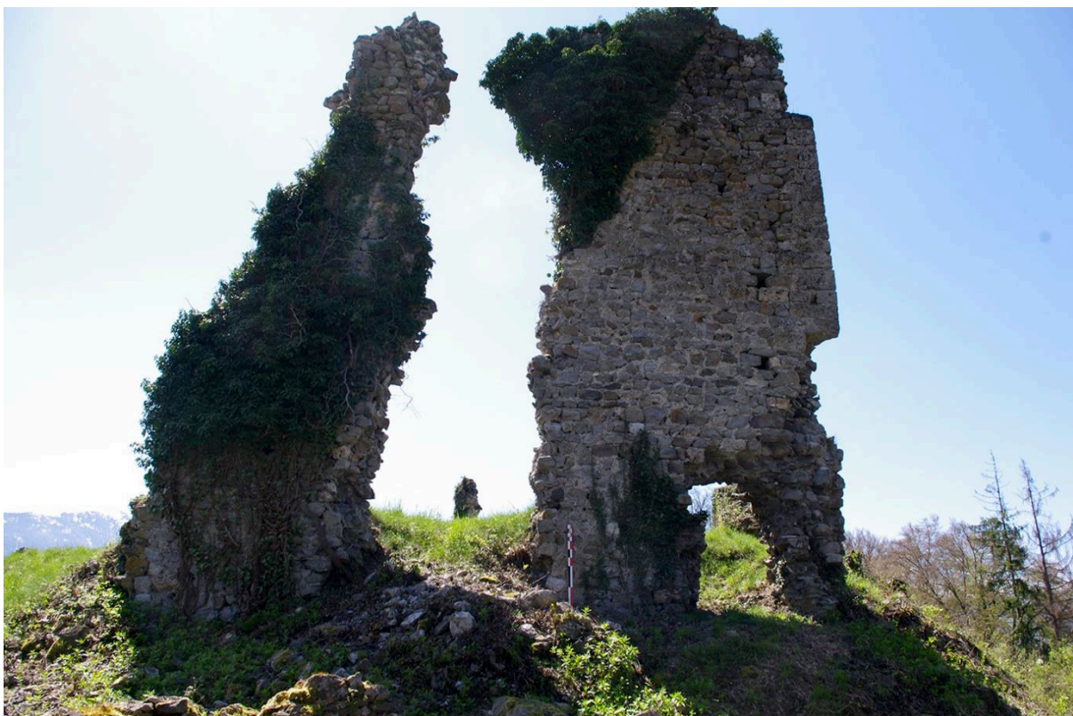
Fig. 8: Mur nord du logis. Cliché : L. Benoit.
