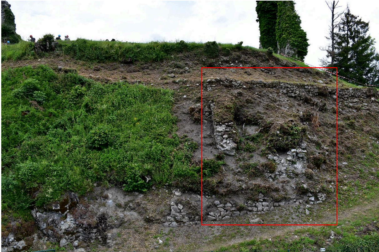
Fig. 11: Vestiges de la tour porte. Cliché : A. Lorphelin.
