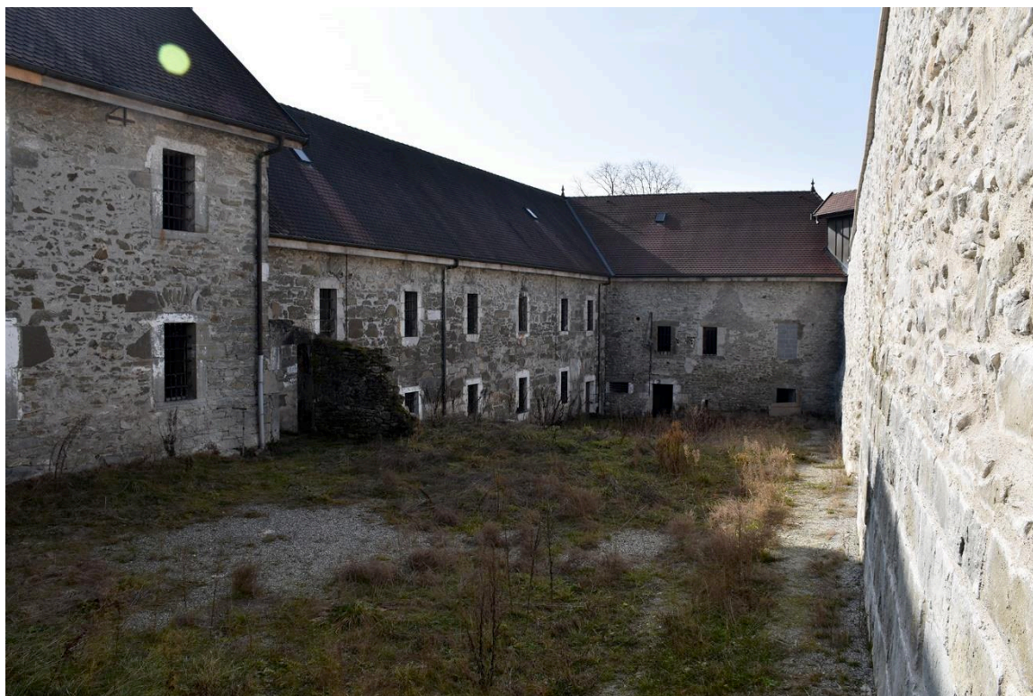
Fig. 29: Bâtiments des prisons présents dans la cour ouest. Cliché : L. Benoit.
