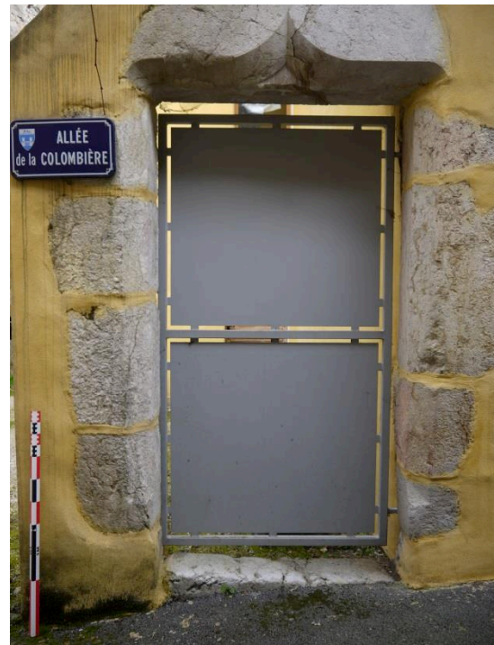
Fig. 10: Porte à linteau en accolade en calcaire. Cliché : L. Benoit.
