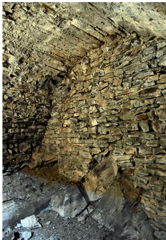
Fig. 20: Salle voûtée découverte sous le bâtiment nord. Cliché : L. Benoit.
