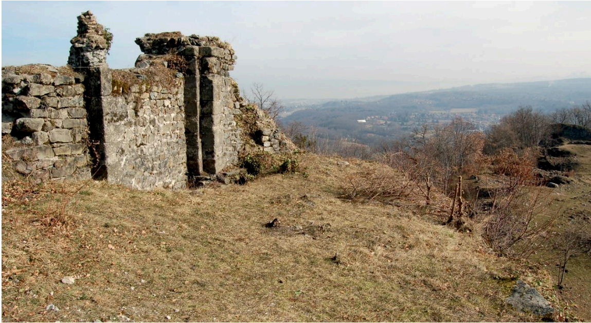
Fig. 37: Chapelle de Château-Vieux. Cliché : L. D'Agostino.
