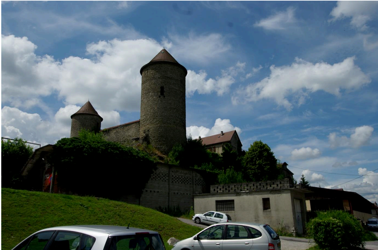
Fig. 2: Vue d'ensemble du château de Bonneville. Cliché : C. Guffond.
