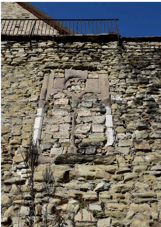
Fig. 24: Baie gémminée présente au sein de la magna aula et installée dans la courtine sud. Cliché : L. Benoit.
