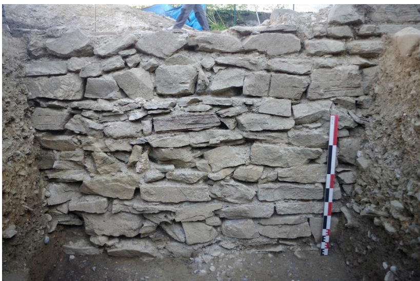
Fig. 17: Mur sud du bâtiment nord. Cliché : L. Benoit.
