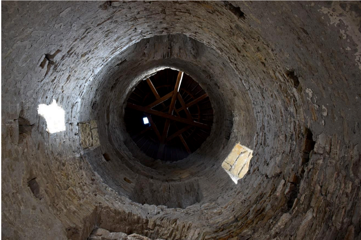
Fig. 11: Intérieur de la tour maîtresse avant restauration. Cliché : L. Benoit.
