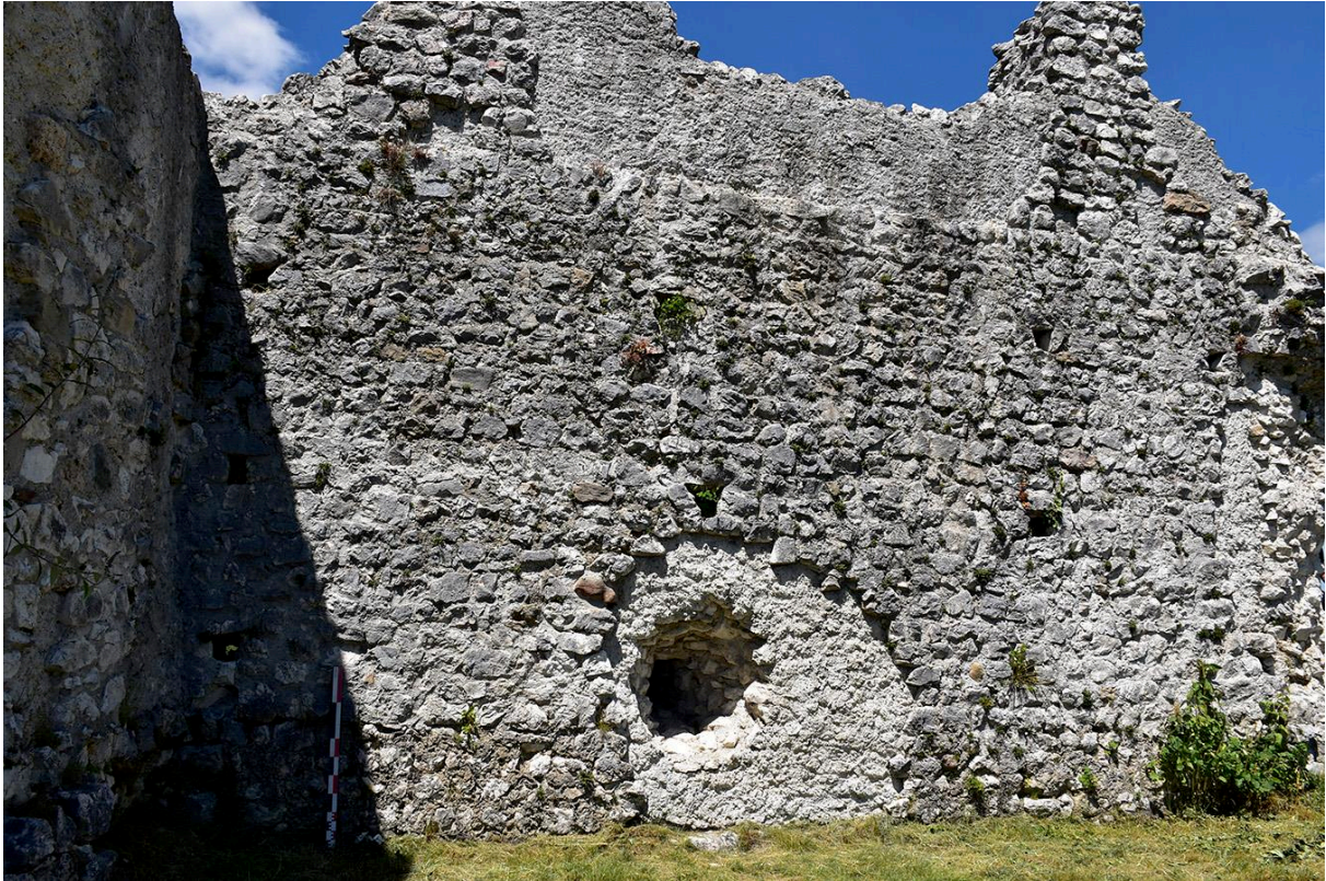
Fig. 6: Appareillage du mur nord de la tour. Cliché : L. Benoit.
