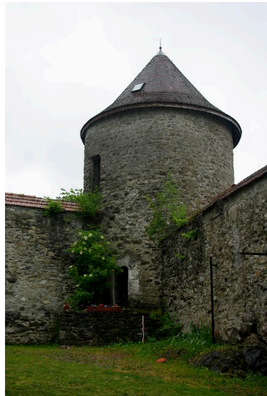
Fig. 15: Vue générale de la tour sud-est avant restauration. Cliché : C. Guffond.
