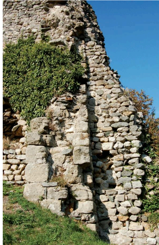
Fig. 30: Contrefort et parement du premier état de construction. Cliché : L. D'Agostino.
