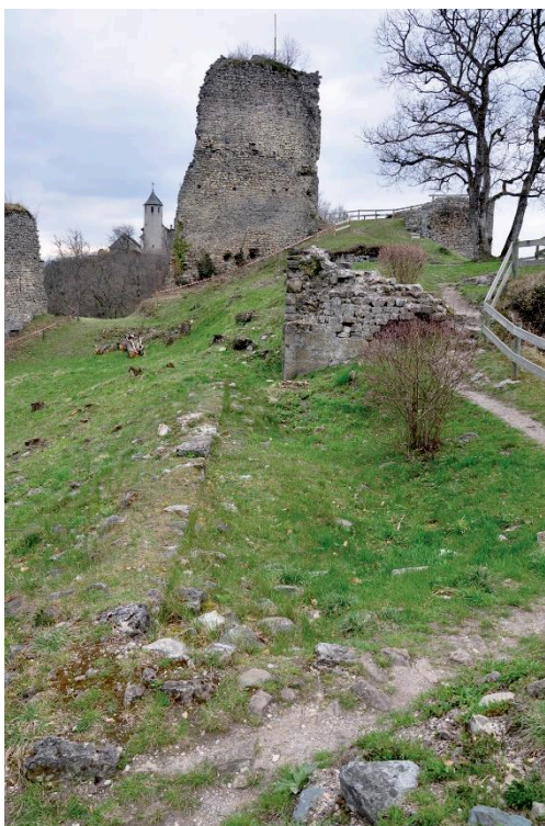
Fig. 35: Intérieur de la cour haute. Cliché : L. D'Agostino
