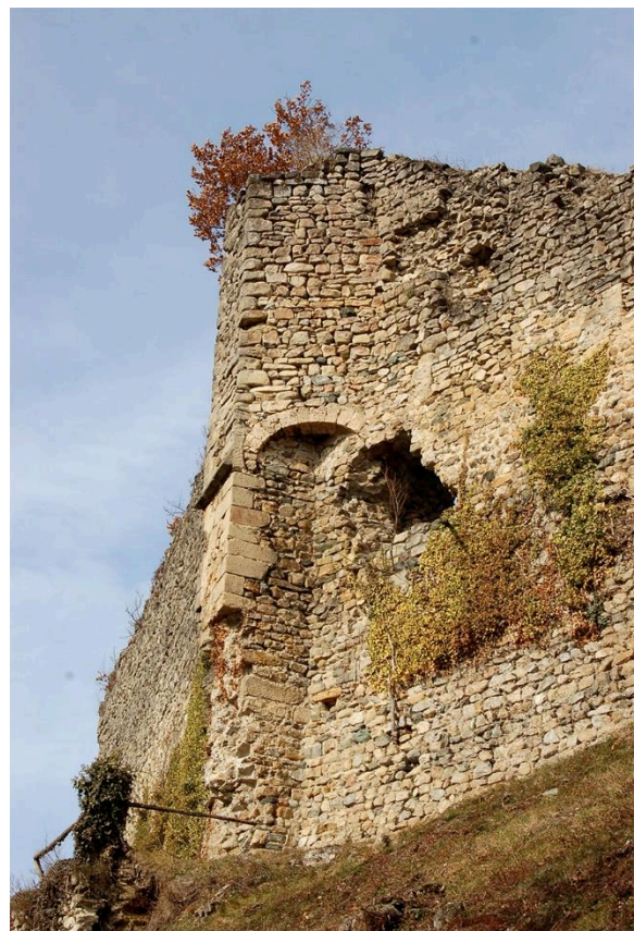
Fig. 33: Courtine sud-est vue depuis l'extérieur. Cliché : L. D'Agostino.
