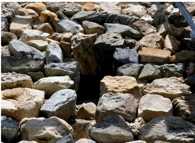
Fig. 31: Evacuation de latrine. Cliché : E. Chauvin-Desfleurs.
