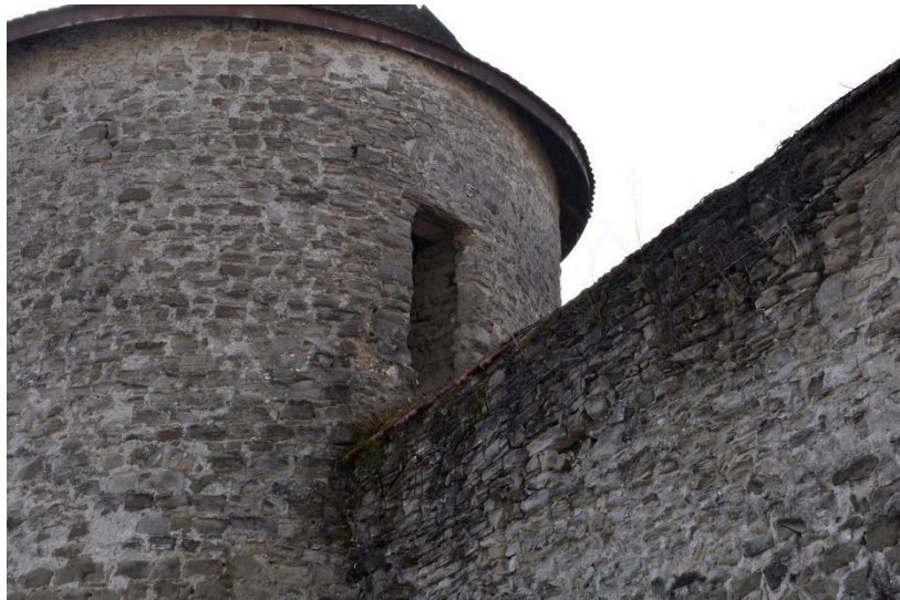
Fig. 13: Porte d'accès au chemin de ronde oriental. Cliché : L. Benoit.
