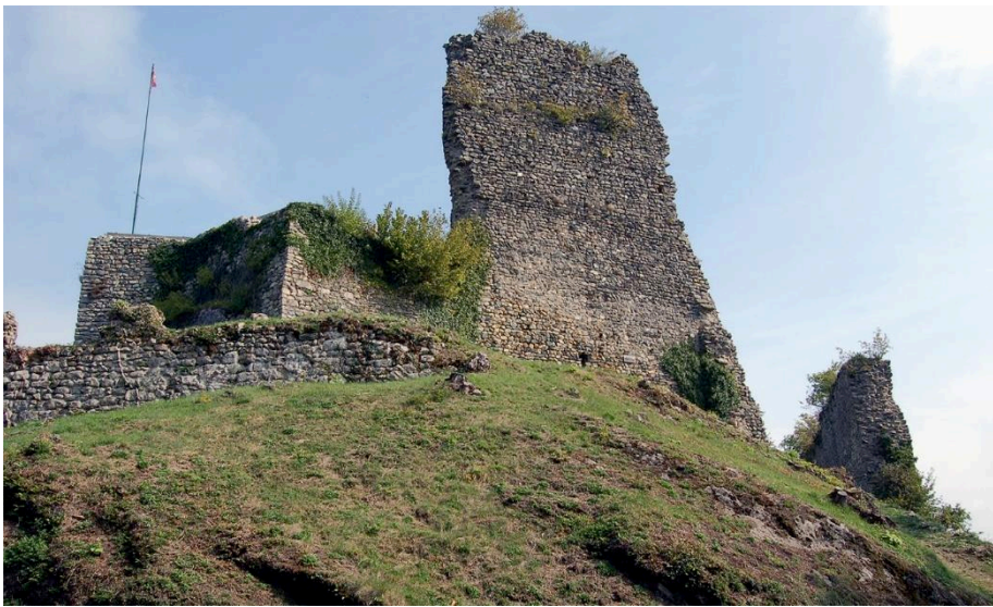
Fig. 29: Le front d'attaque sud-ouest de Château-Vieux. Cliché : L. D'Agostino.
