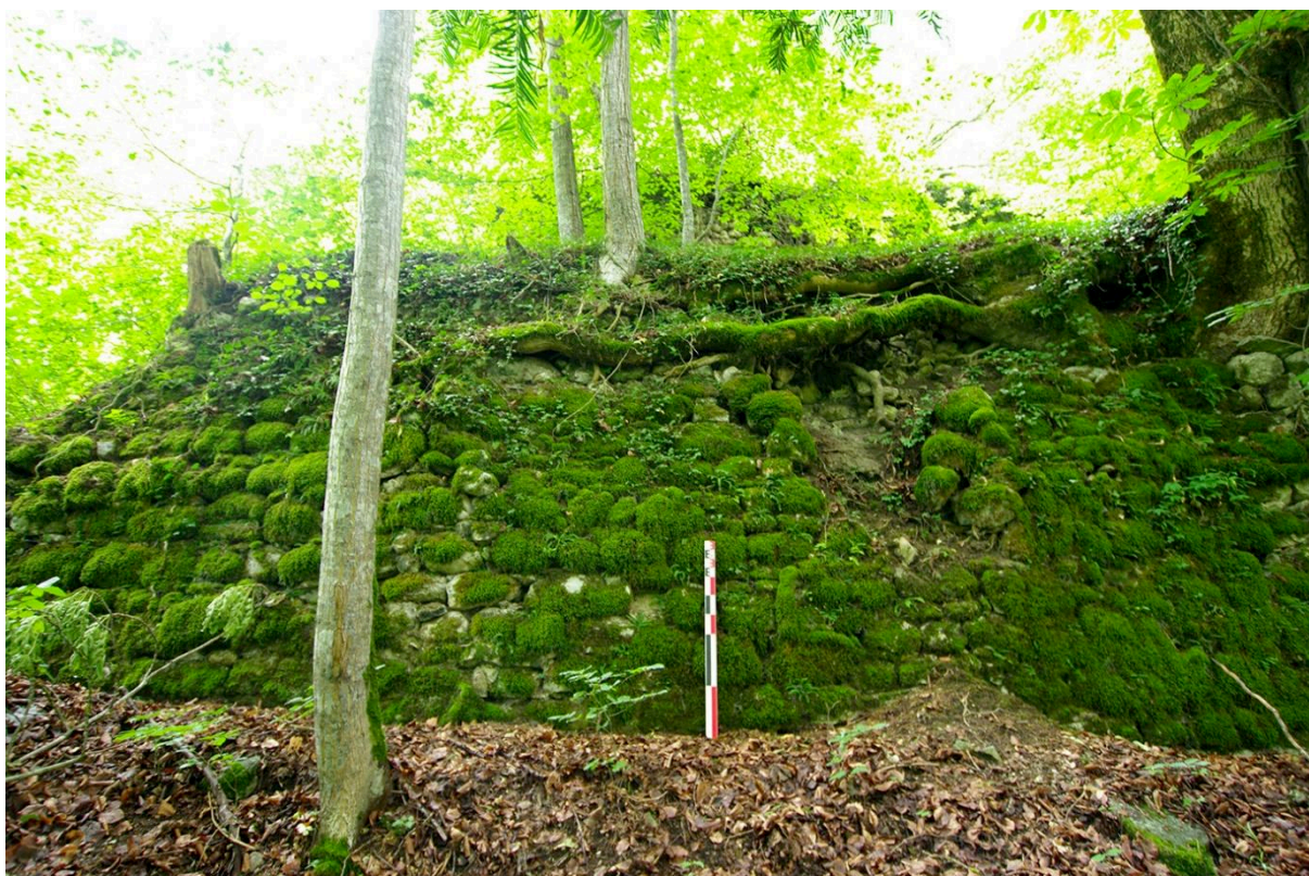
Fig. 5: Potentielle braie entourant le château de Cusy. Cliché : C. Guffond.
