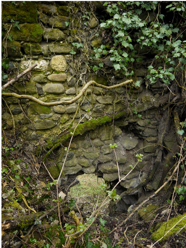
Fig. 2: Parement intérieur de la tour maîtresse. Cliché : L. Benoit.
