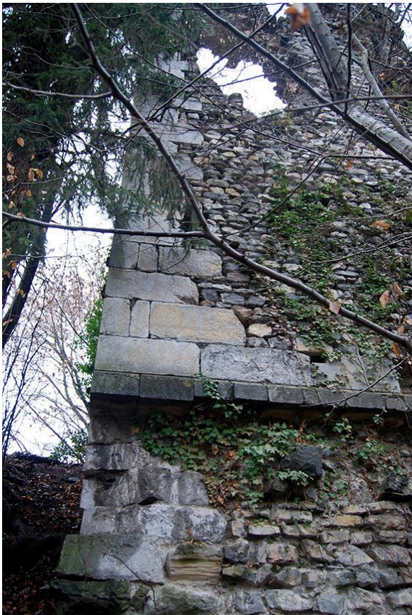
Fig. 6: Utilisation de la pierre de taille sur la tour d'Ugine. Cliché : L. Benoit.
