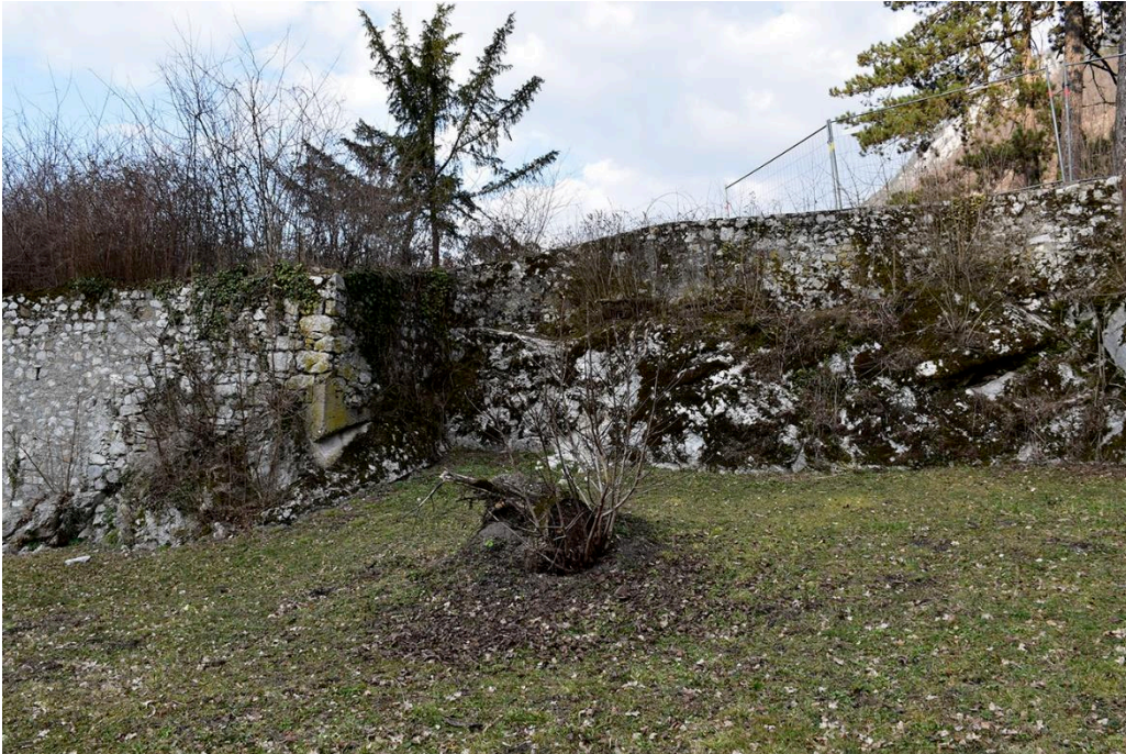
Fig. 5: Fondations des maçonneries sur le substrat géologique. Cliché : L. Benoit.
