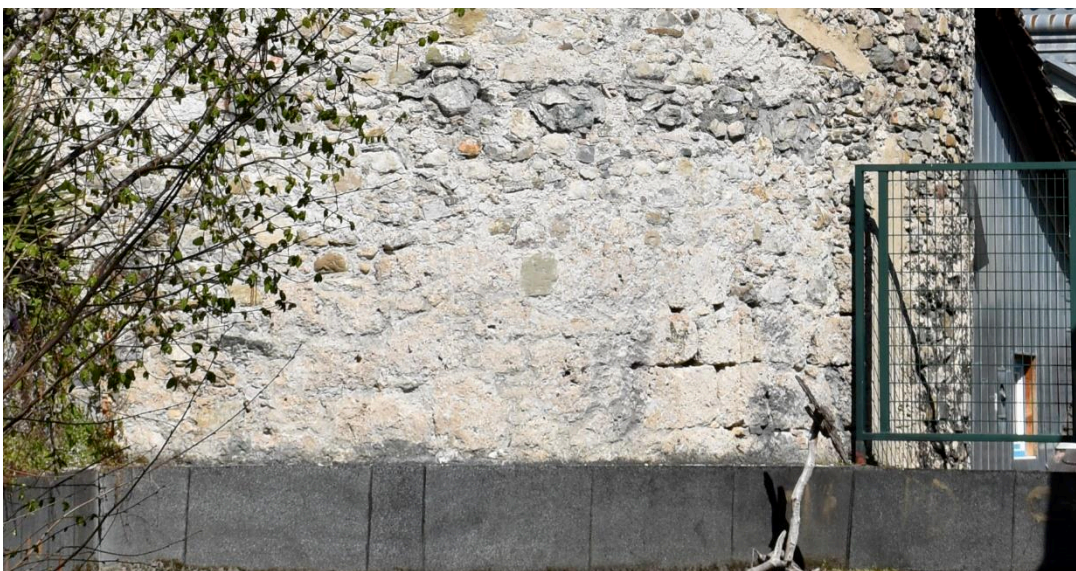
Fig. 4: Détail du parement en pierres de taille de tuf. Cliché : L. Benoit.
