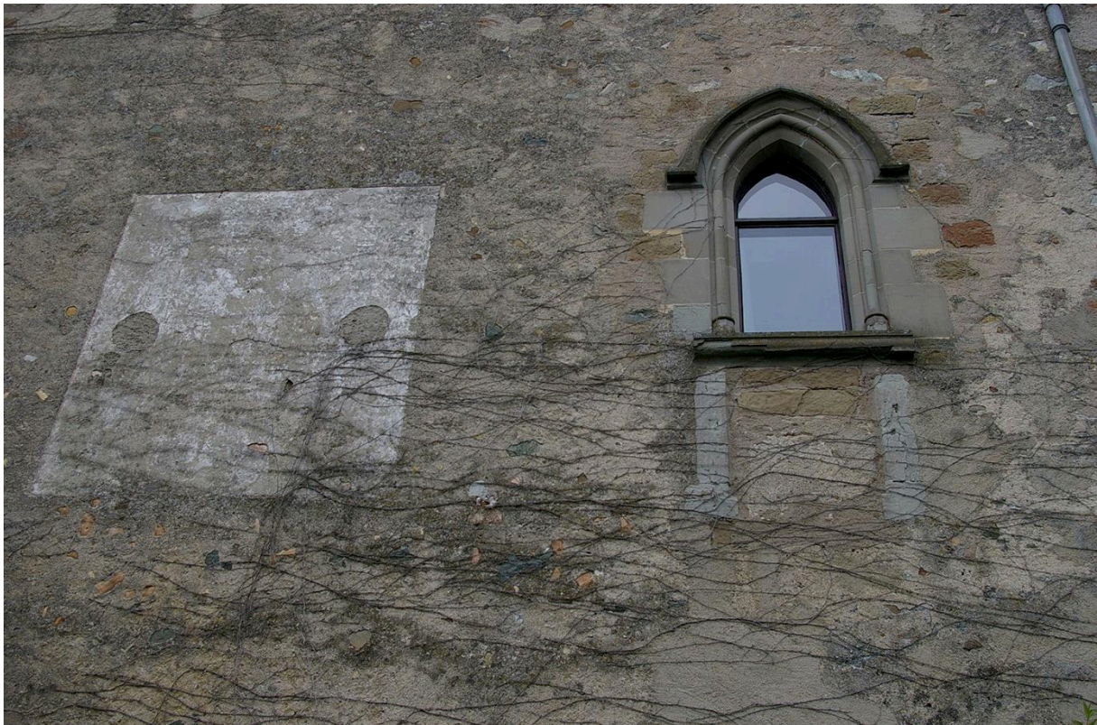
Fig.3: Appareil de construction visible en partie. Cliché : C. Guffond.
