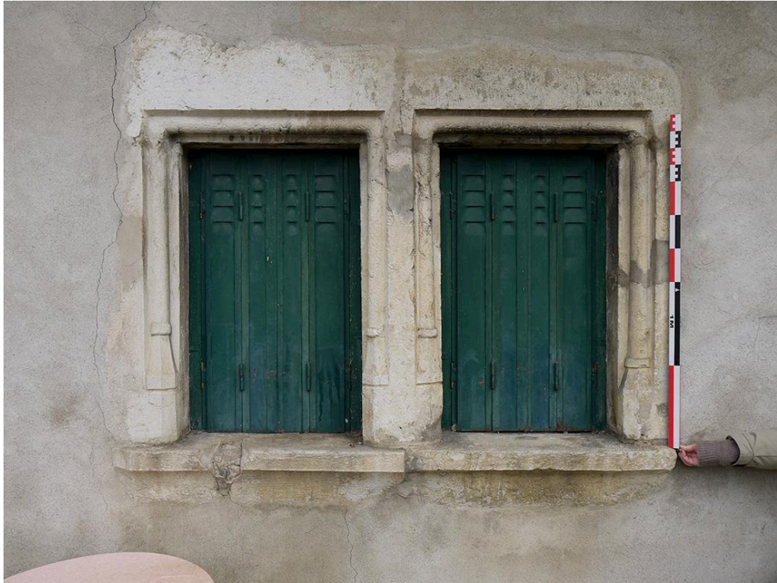
Fig. 9: Fenêtre à meneau et congés imitant une colonne engagée. Cliché : L. Benoit.
