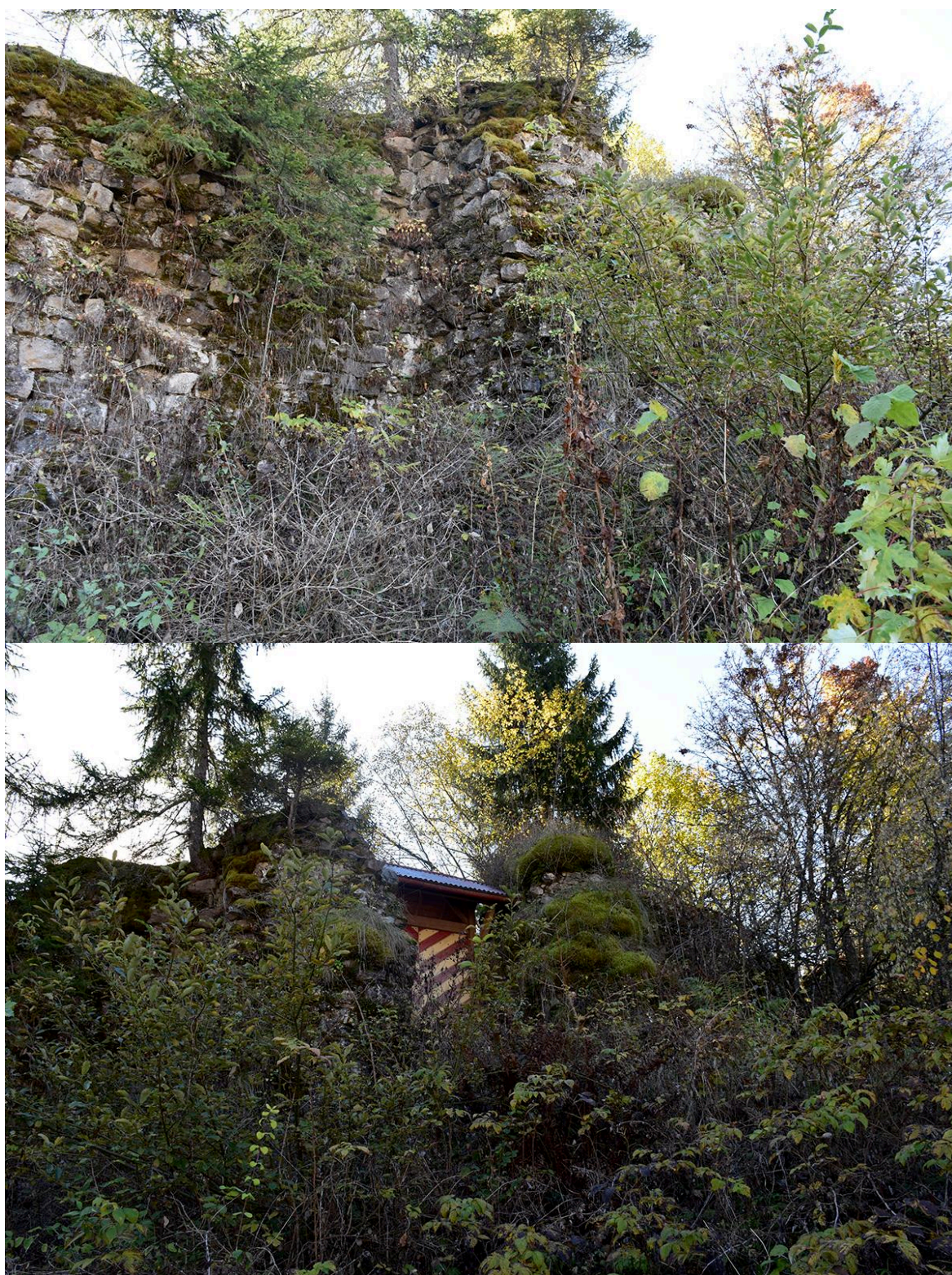
Fig. 3: Détails des vestiges de la tour porte du château. Clichés : L. Benoit.
