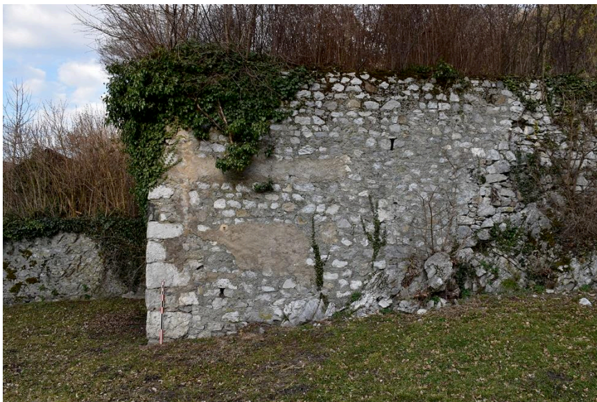
Fig.4: Potentielle maçonnerie associée au château. Cliché : L. Benoit.
