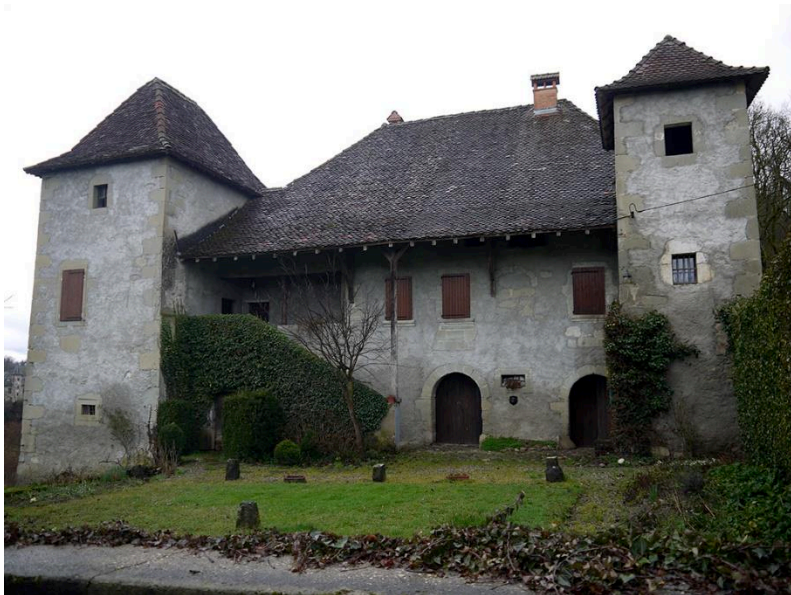
Fig. 8: Façade de la maison forte du Verney. Cliché : L. Benoit.
