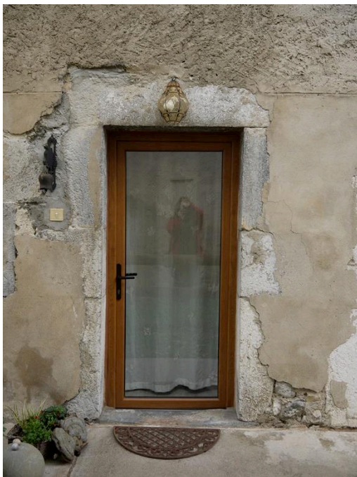
Fig. 8: Porte à linteau plat. Cliché : L. Benoit.
