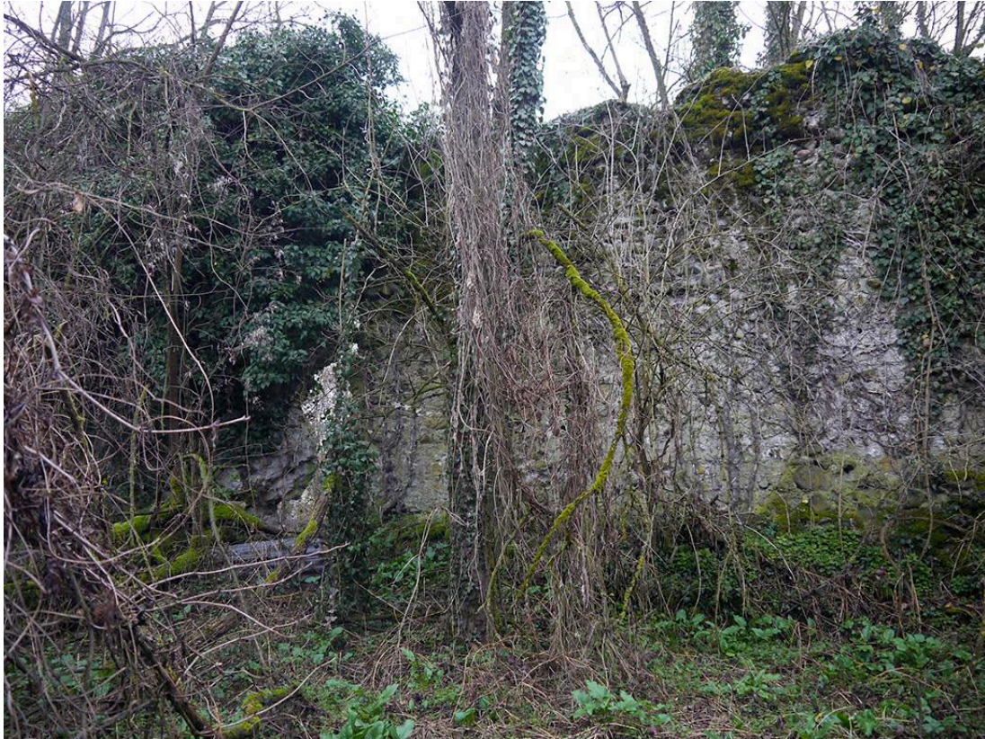
Fig. 7: Clôture maçonnée au centre du château. Cliché : L. Benoit.
