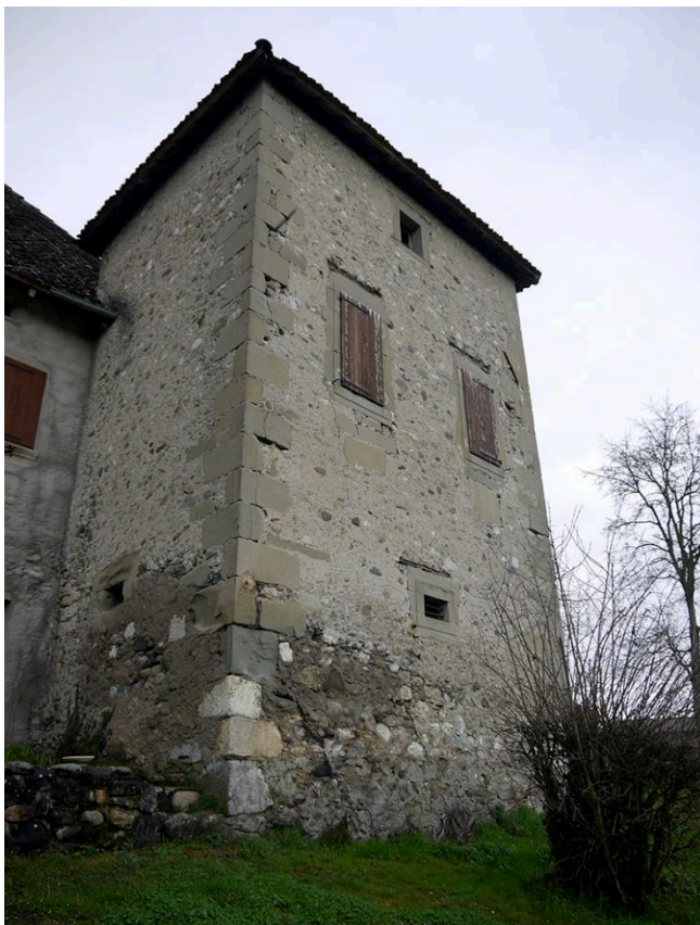
Fig. 9: Appareil de construction de la maison forte. Cliché : L. Benoit.
