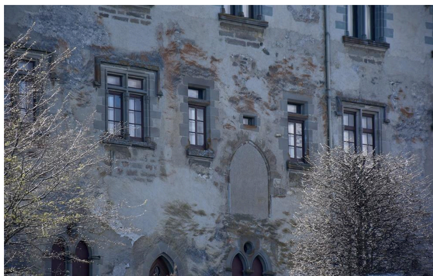
Fig.4: Ancienne porte conservée sur la façade nord. Cliché : L. Benoit.
