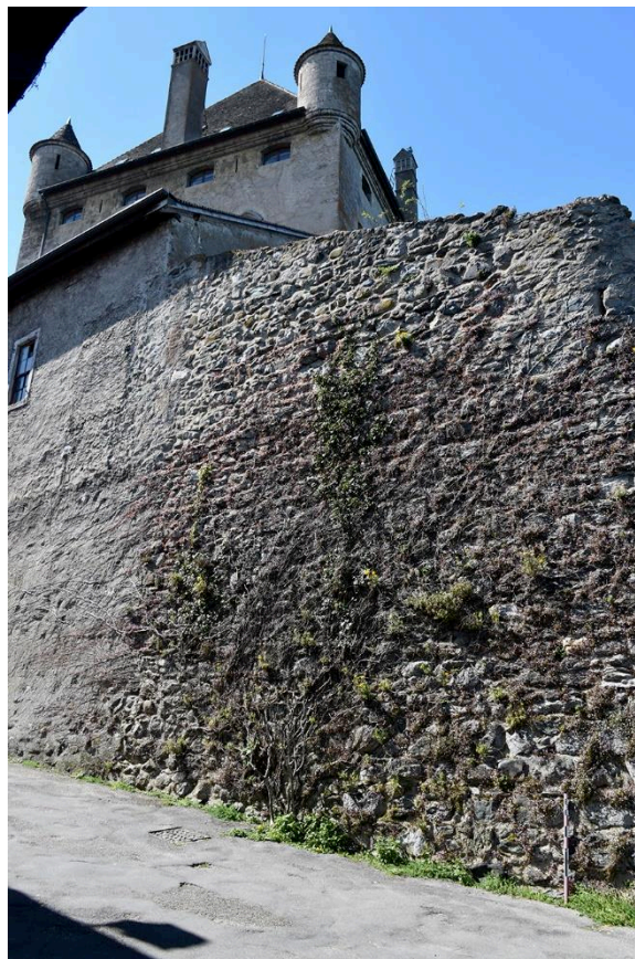
Fig. 9: Enceinte nord-est du château. Cliché : L. Benoit.
