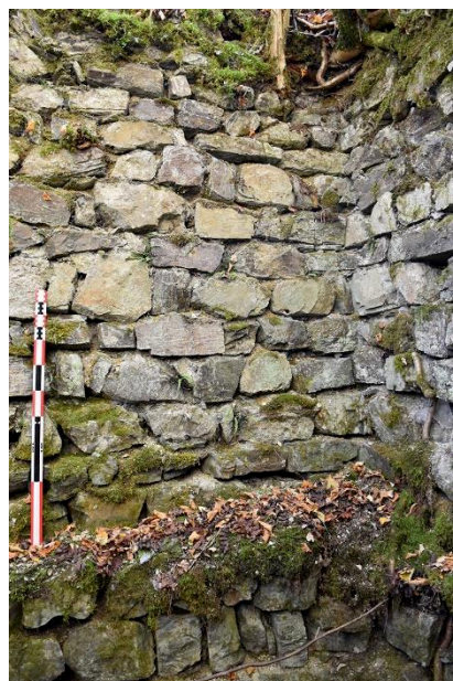
Fig. 6: Trous de boulins et ressaut présents à l'intérieur de la tour. Clichés : L. Benoit.
