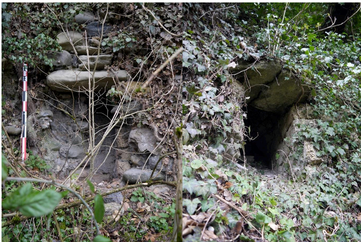
Fig. 4: Conduit de latrine et baie. Clichés : L. Benoit.
