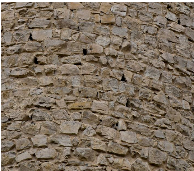
Fig. 3: Détail du parement extérieur de la tour. Cliché : L. Benoit.
