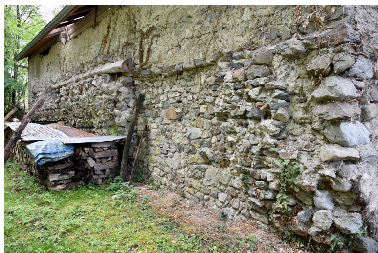
Fig. 3: Courtine comprise dans une construction récente. Cliché : L. Benoit.
