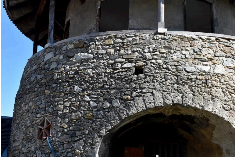
Fig. 3: Détail du parement supérieur de la tour. Cliché : L. Benoit.
