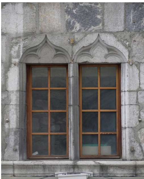
Fig. 14: Fenêtre à accolades. Cliché : L. Benoit.
