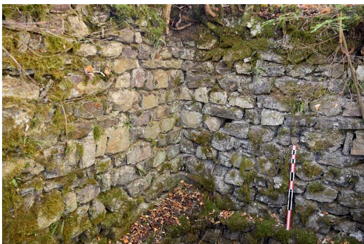
Fig. 6: Trous de boulins et ressaut présents à l'intérieur de la tour. Clichés : L. Benoit.
