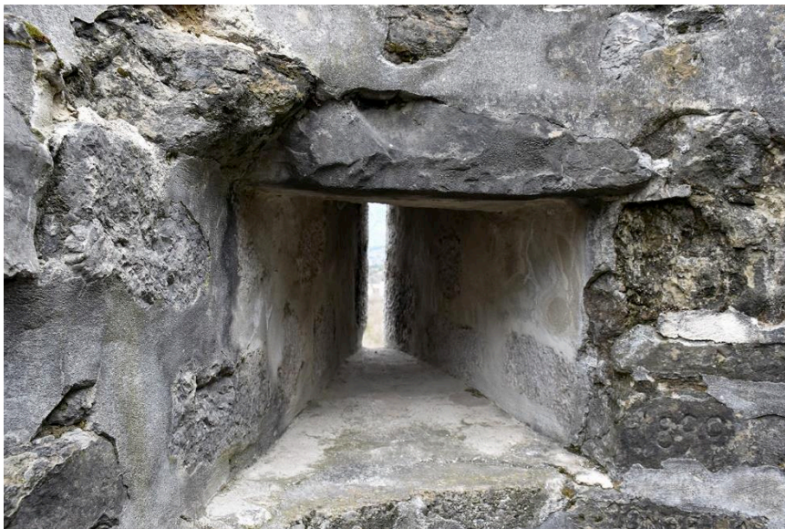
Fig. 6: Ouverture dans la cage d'escalier interne de la tour. Cliché : L. Benoit.
