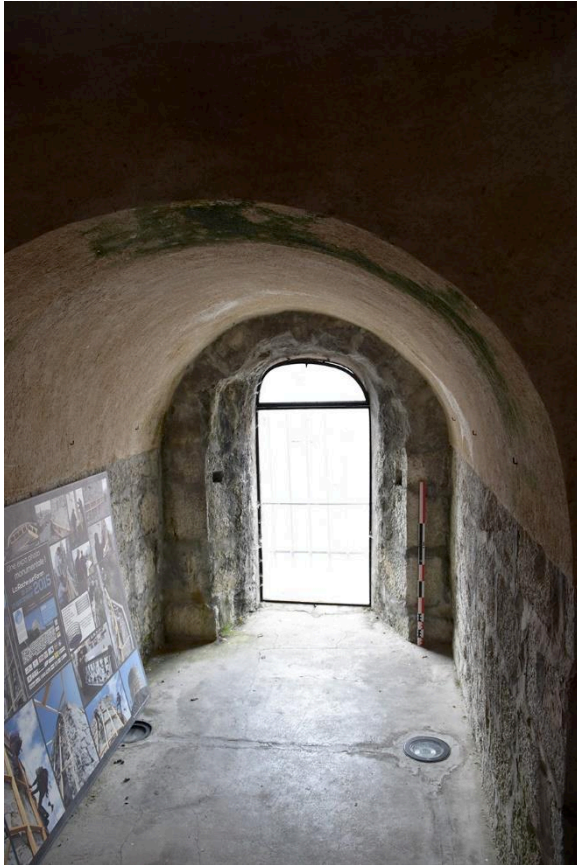
Fig. 5: Baie nord de la tour de La Roche. Cliché : L. Benoit.
