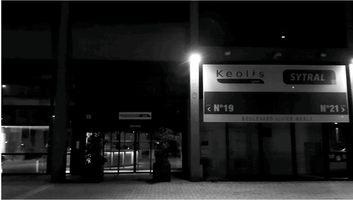
FIGURE 5 – Bâtiment « Le B12 », siège mitoyen.
