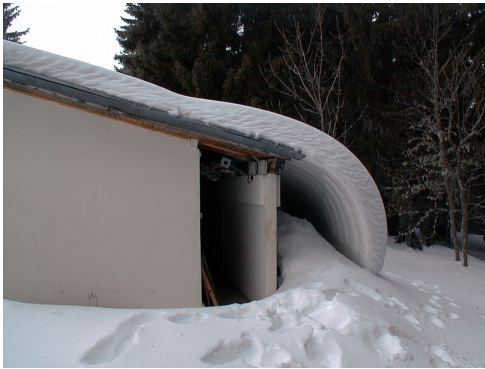
Figure 1.3 – La plaque de neige glisse du toit et se courbe sans se rompre. La déformation sans rupture de la neige est l'illustration d'un comportement ductile.
