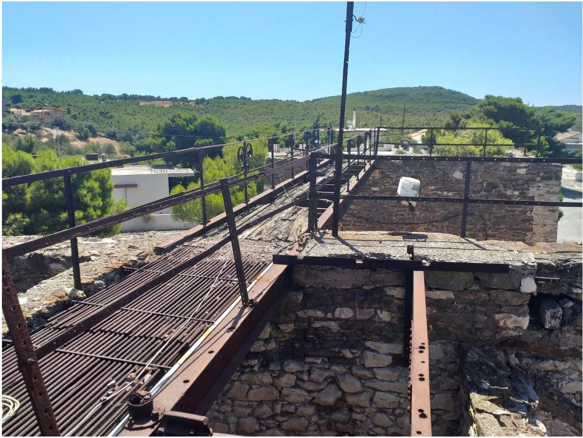
42. Fig.5-42 Passerelle-pont métallique, Photographie, Christina Mamaloukaki, 2019.
