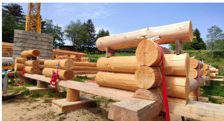
Le rondin marqué est ensuite descendu, positionné face à travailler sur le dessus : la gorge, dont les pourtours ont été tracés, est délimitée très précisément avec la tronçonneuse puis taillée : l'évidement central est effectué en adaptant sur la tronçonneuse un outil permettant de creuser : un rabot fraise. La profondeur de la gorge : de 2,3 à 2,5 cm.
