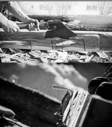
L'équarrissage à la hache est la technique qui fut la plus utilisée pour le façonnage des poutres dans l'histoire de la charpente. Elle a de grands avantages:
