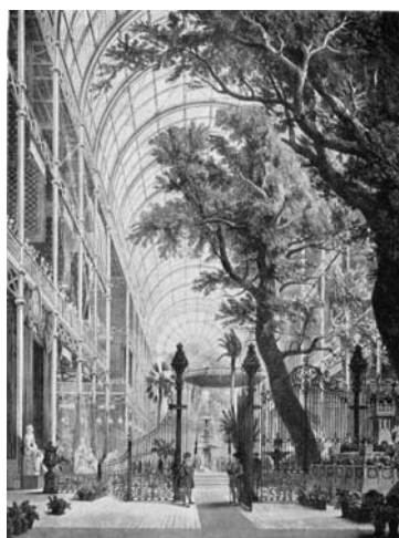
33. Vue du transept du côté sud.
