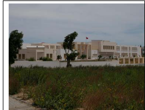
17. Vue de la façade principale. Mai 2003.
