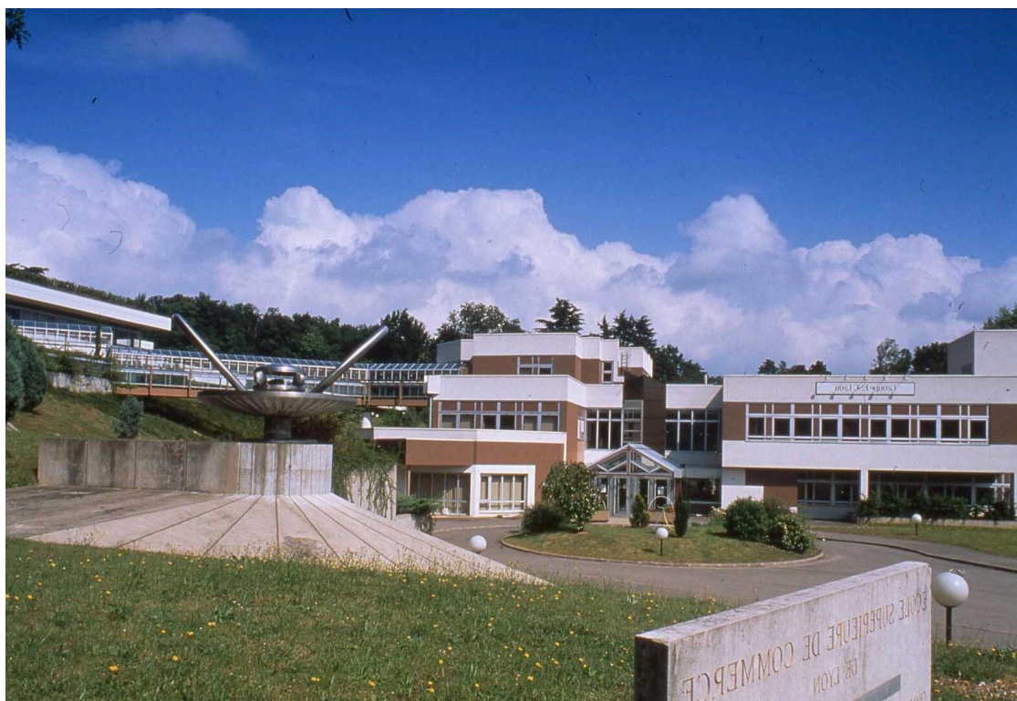
Figure 20 : Campus de l'école supérieure de commerce de Lyon à Écully (années 1970) 660
