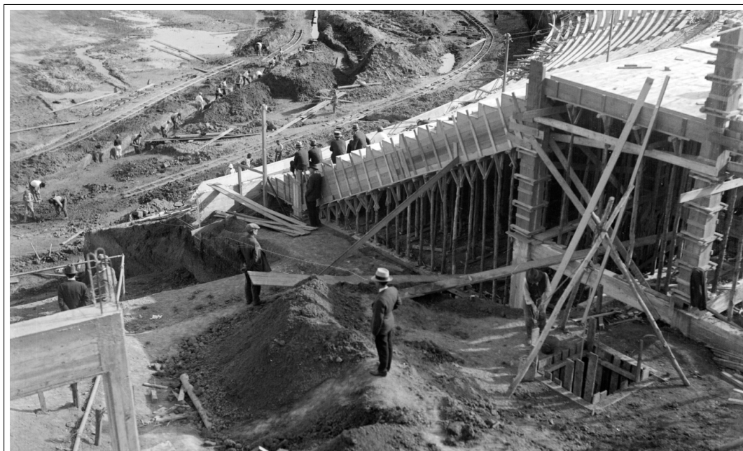
FIGURE 8.5 – Groupes de curieux inspectant l’avancée des travaux au niveau de la jonction entre les tribunes Amsterdam (à gauche) et Olímpica (à droite). Photographie, détail, Centro de Fotografía de Montevideo, s.d., 1613FMHB.
