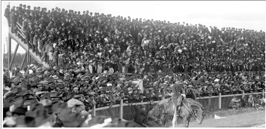
FIGURE 3.9 – Vue des gradins du stade Parque Central lors d'un match de football. Au premier plan, un officier de police montée est posté au point de corner. Montevideo, circa 1917. Photographie, détail, Centro de Fotografía de Montevideo, s.d., 01525FMHGE.
